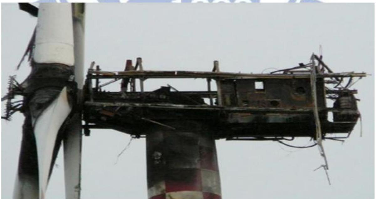
圖 2 正隆紙廠風力發電機火災後照片
