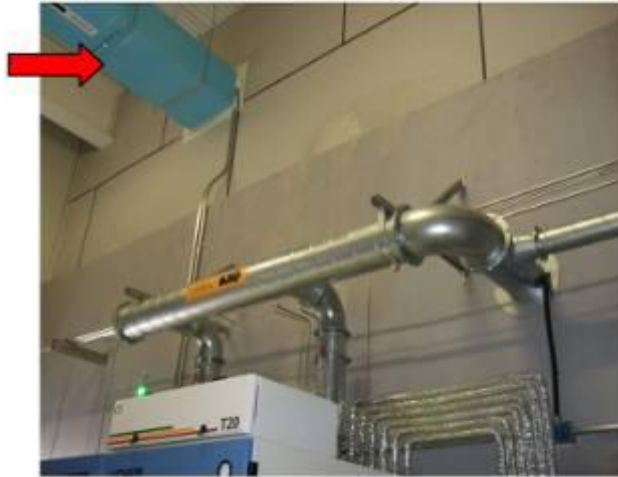
圖 25 二乙基鋅(DEZn)中央配送空調風管增設防火閘門示意圖
