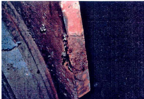
圖 2.12 扭桿構材高應力處銹蝕
