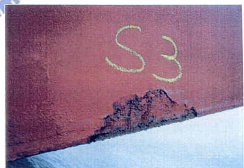
圖 2.7 箱梁角隅處塗膜剝落腐
