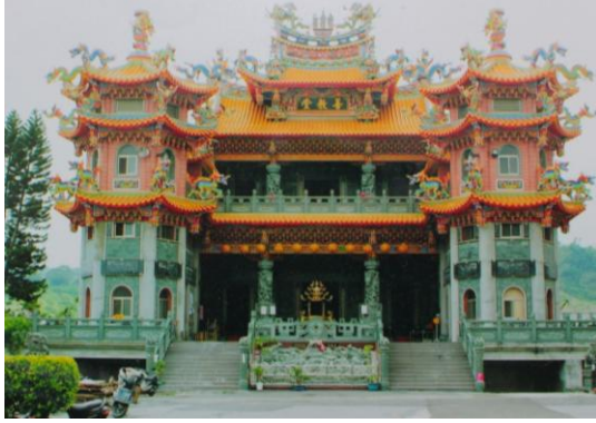
圖 14 九二一地震後重建至今的善教堂 資料來源:下新里劉發現里長提供，筆者翻拍
