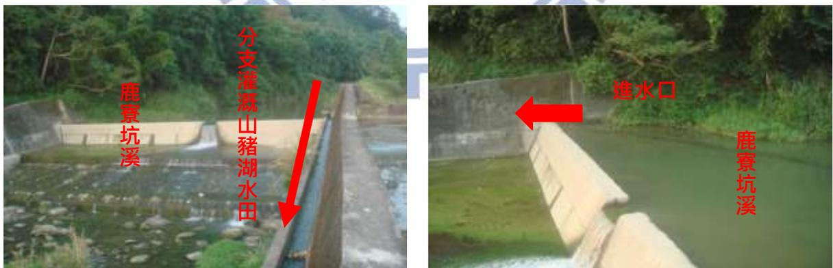
圖 5-4 石壁潭新圳於鹿寮坑溪進水口及分支至灌溉山豬湖水田
