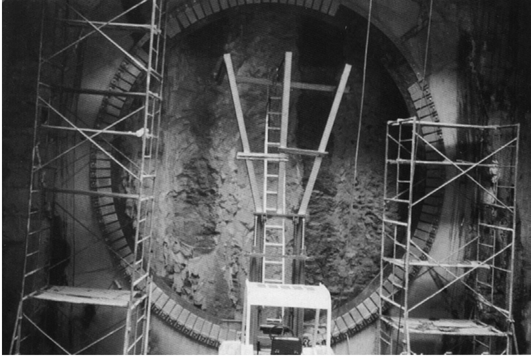
圖 2-35 安裝鏡面止水墊圈及逆止鋼蹠片
