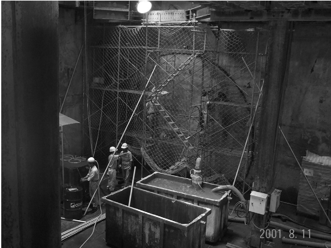
圖 2-31 潛盾機到達將破除之鏡面 (摘自 高宗正, 2003)
