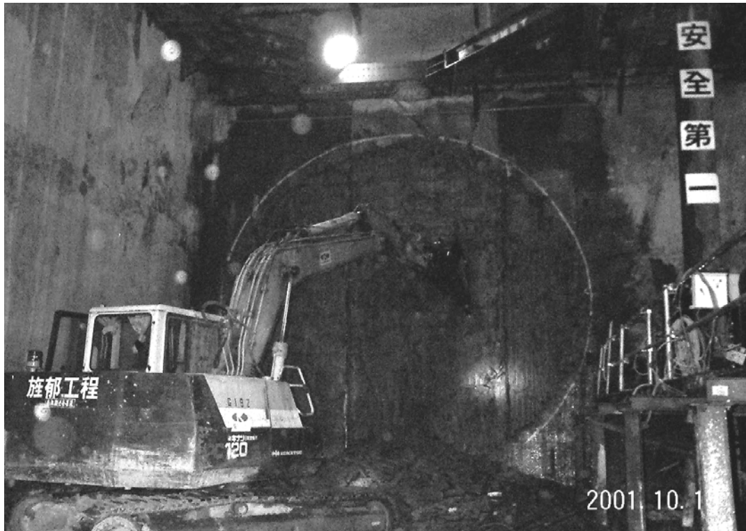
圖 2-33 鏡面破除作業
