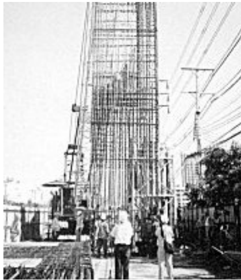
圖 2-41 曼谷捷運 GFRP 纖維筋鋼筋籠 (摘自 Thasnanipan, 2000)
