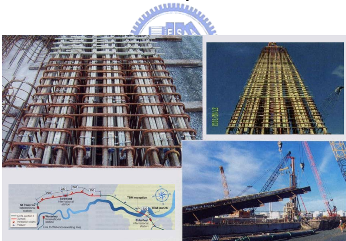
圖 2-41 曼谷捷運 GFRP 纖維筋鋼筋籠 (摘自 Thasnanipan, 2000)
