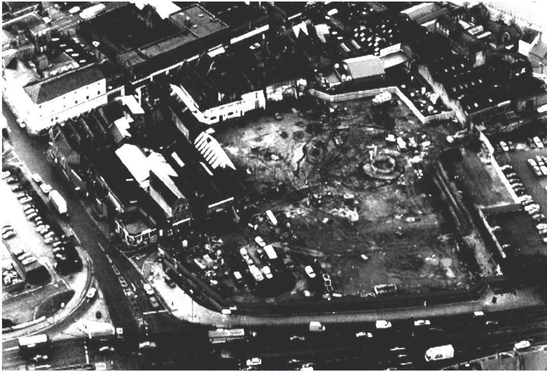
圖 3-8 地表因地盤流失而出現的坑洞
