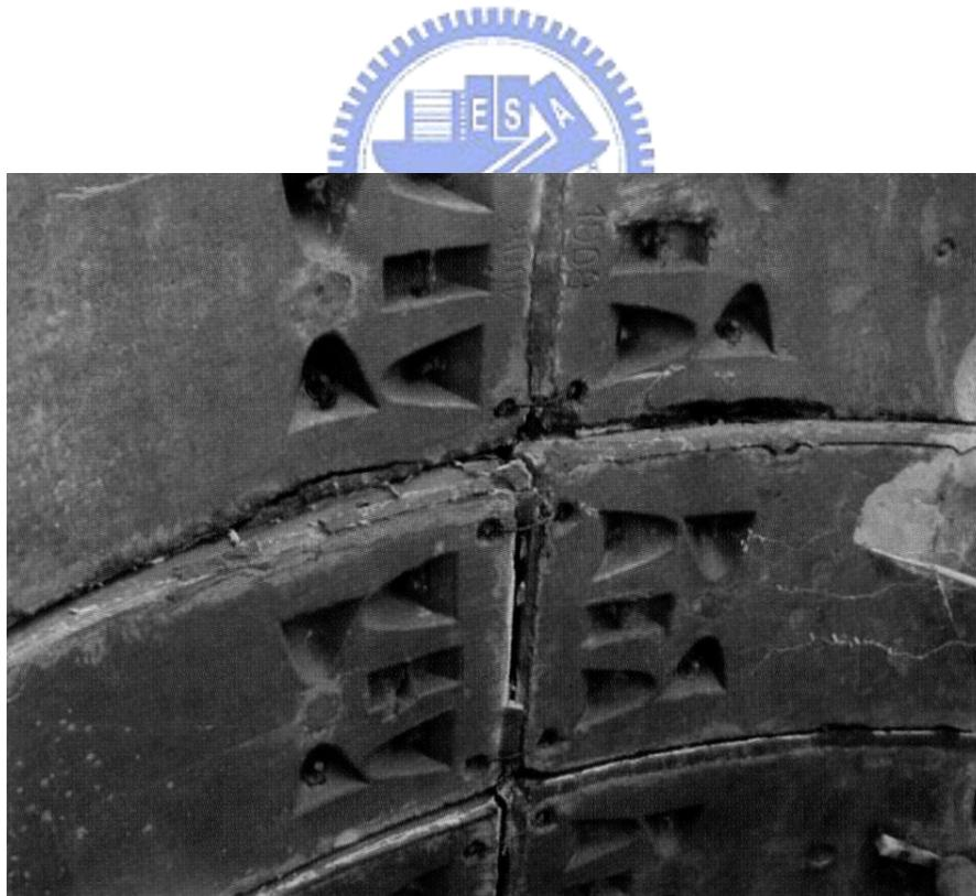
圖 3-14 環片間有裂縫存在，某部分甚至損毀
