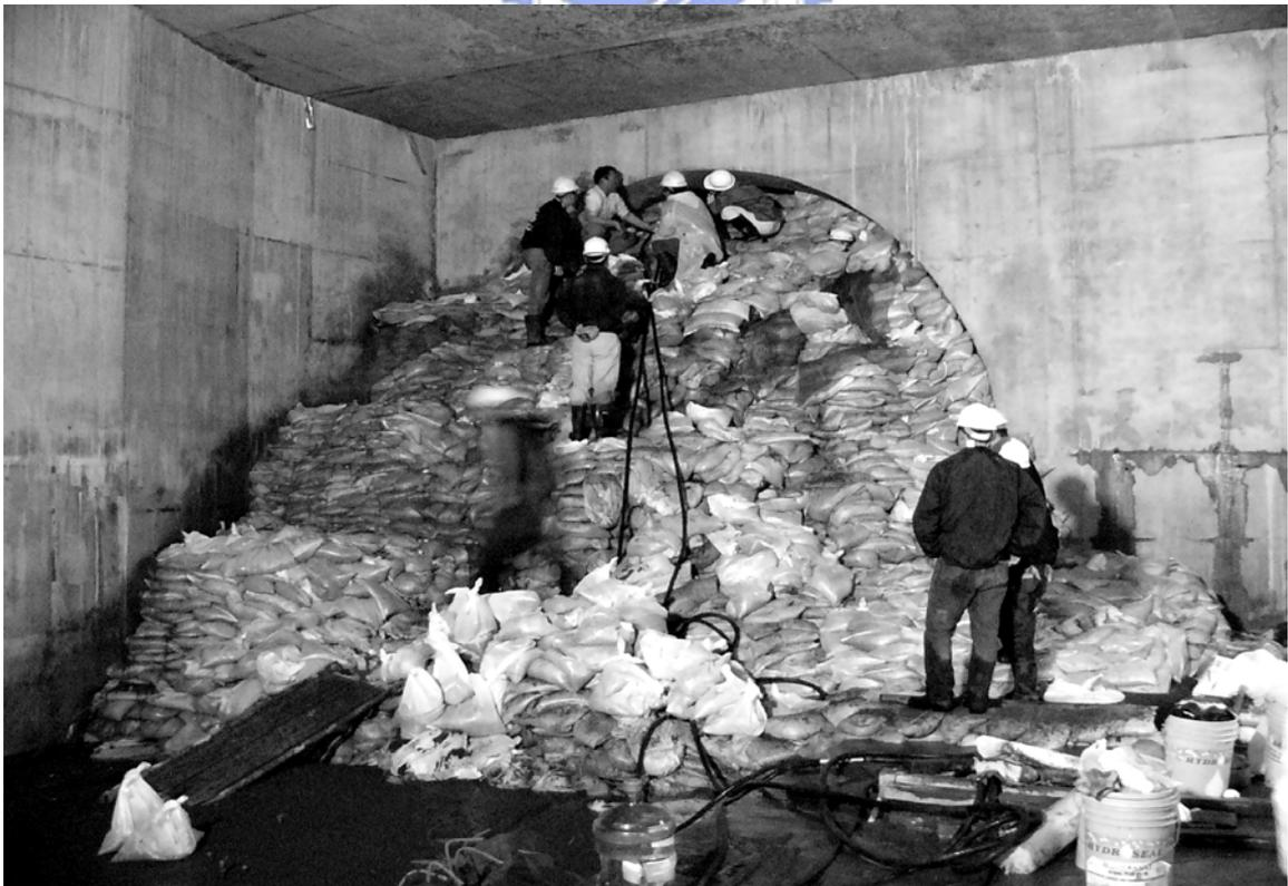
圖 5-19 接頭滲水處注入急速固結型化學灌漿材料
