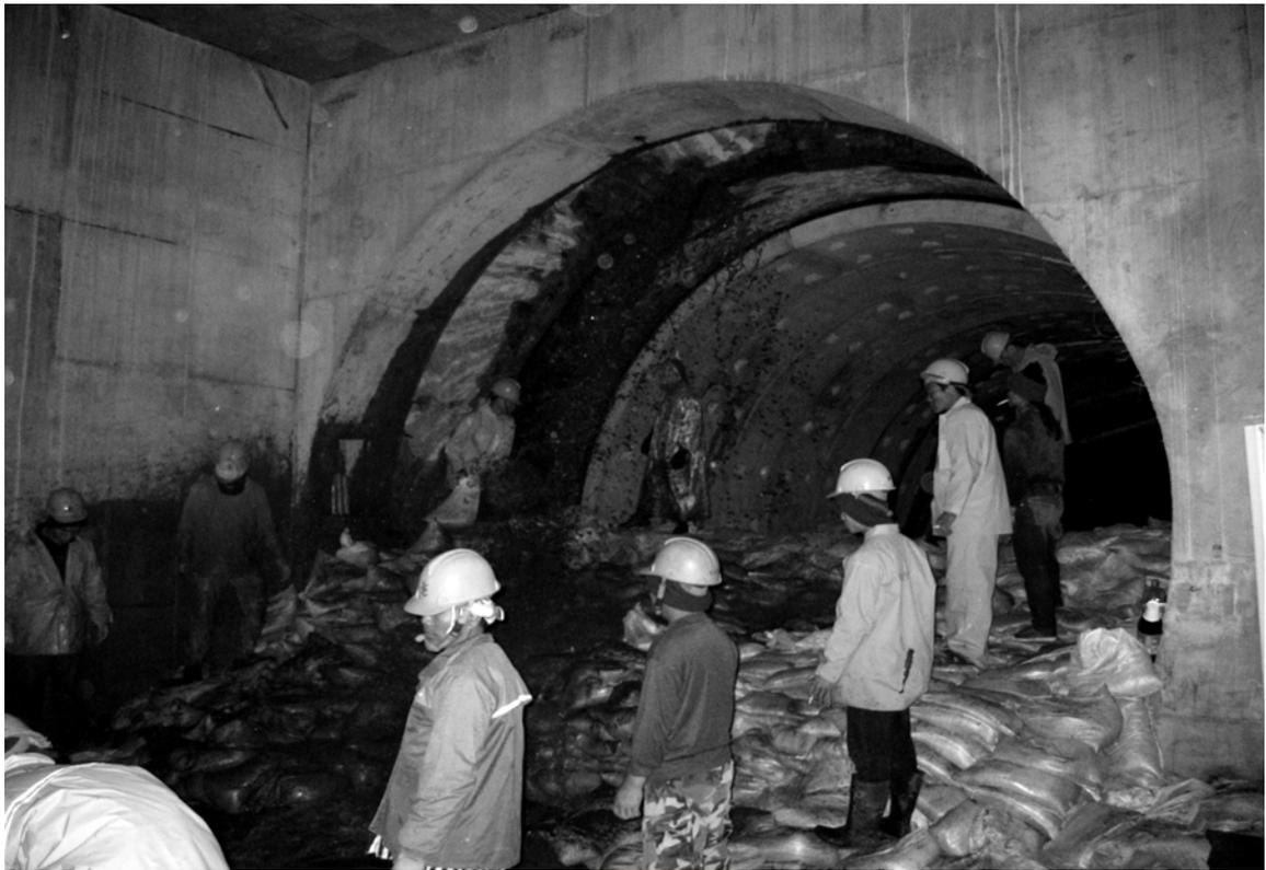
圖 5-18 隧道內止水砂包堆積情形
