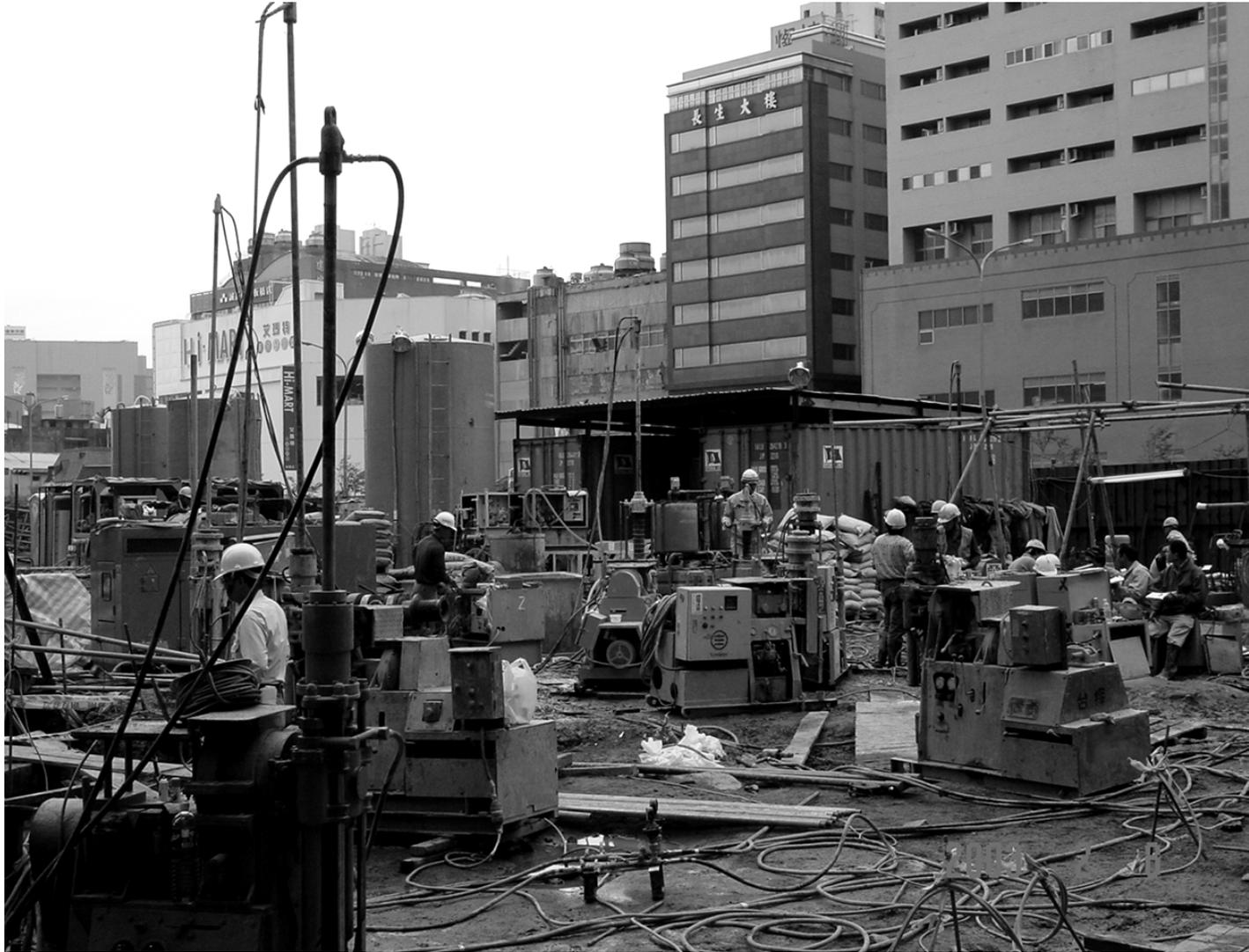
圖 5-28 鏡面止水灌漿
