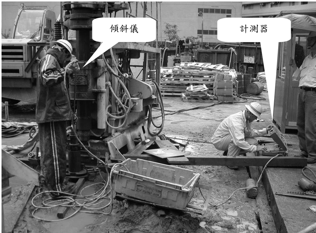
圖 5-44 冷凍管外管傾斜測定作業 (摘自 大陸工程, 2003)
