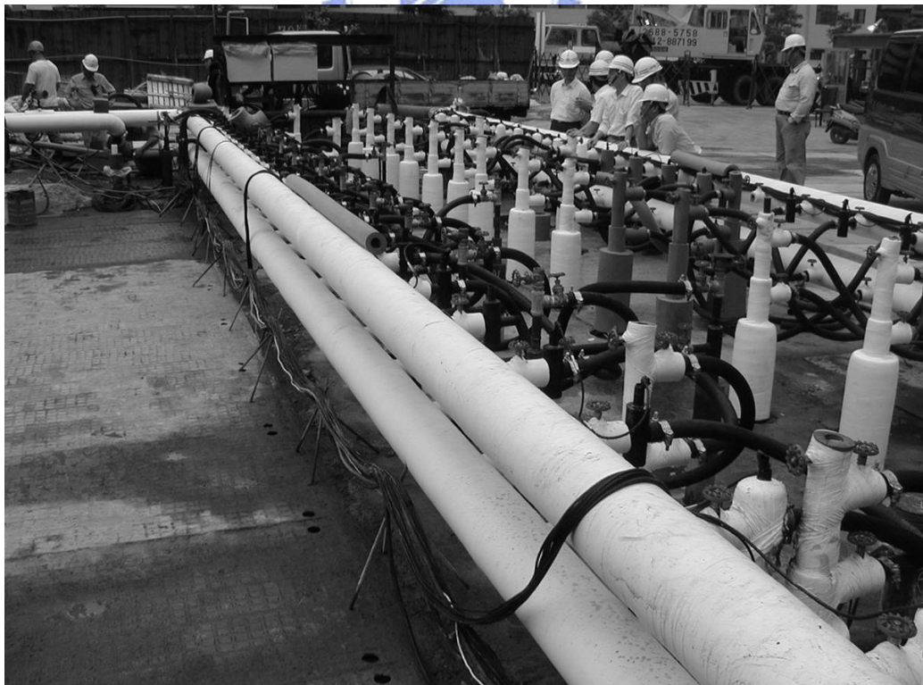
圖 5-45 冷凍工法保溫材包覆作業 (摘自 大陸工程, 2003)
