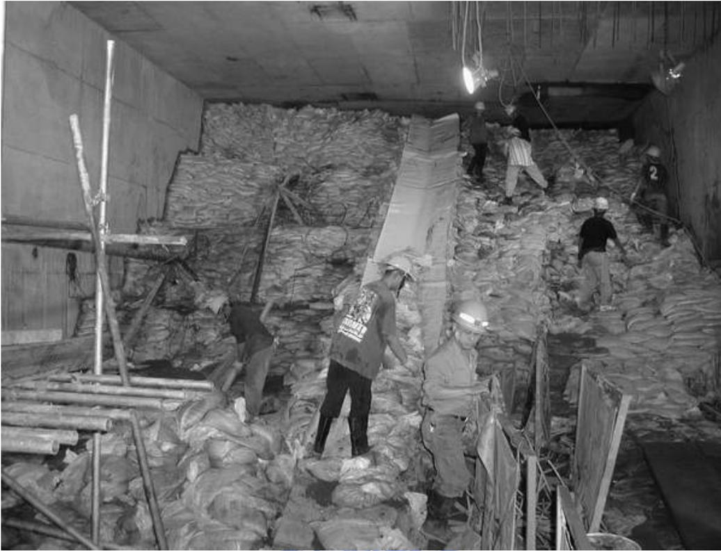
圖 5-49 隧道頂拱砂包清除作業 (摘自 大陸工程, 2003)
