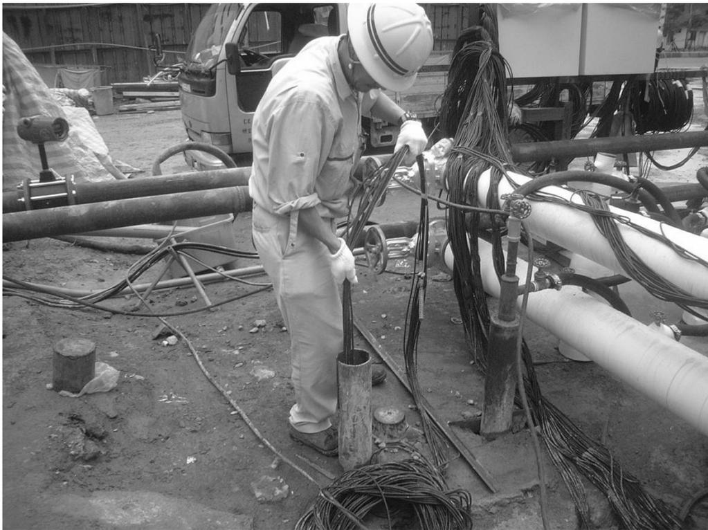
圖 5-46 測溫管內置入測溫端子 (摘自 大陸工程, 2003)
