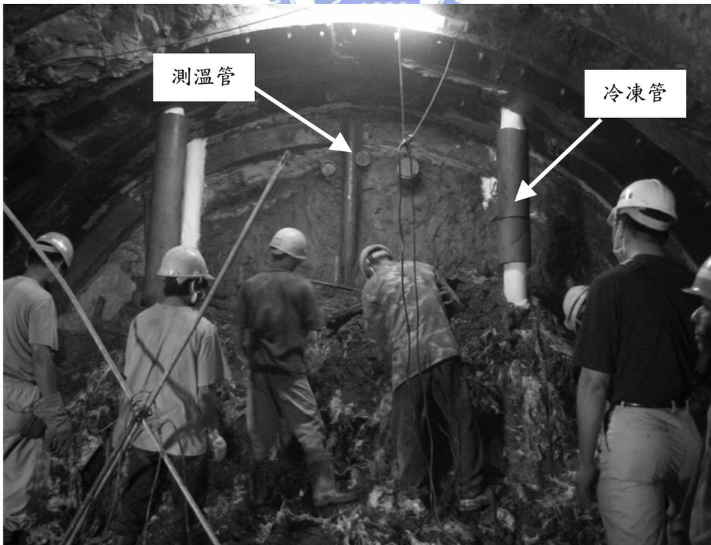
圖 5-50 隧道洞口處以小型破碎機進行砂包撤除作業
