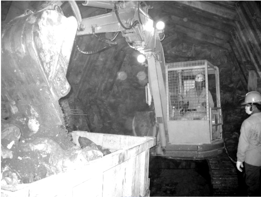
圖 5-59 隧道內砂包撤除作業 (摘自 大陸工程, 2003)
