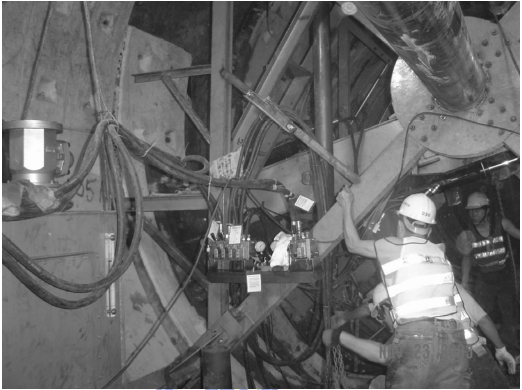
圖 5-63 利用環片組裝機移除環片 (摘自 大陸工程, 2003)
