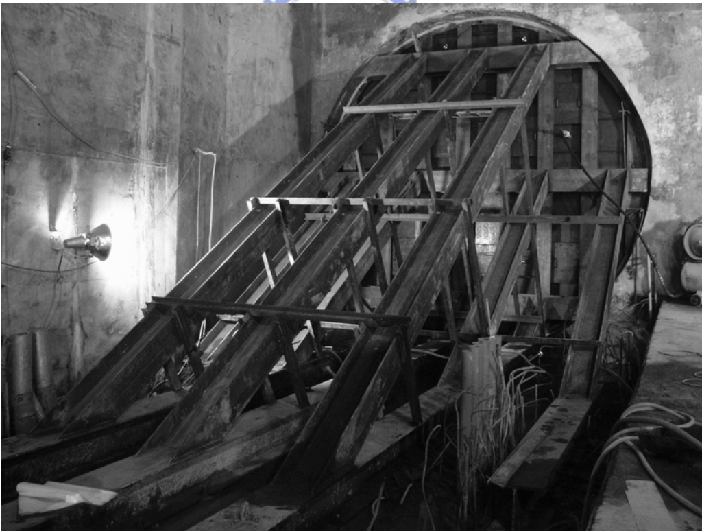
圖 5-56 隧道洞口 NO.1 隔艙設置完成 (摘自 大陸工程，2003)
