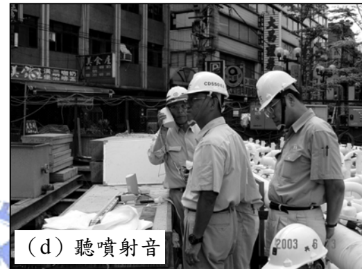
圖 6-7 SJM 地盤改良之噴射音確認過程
