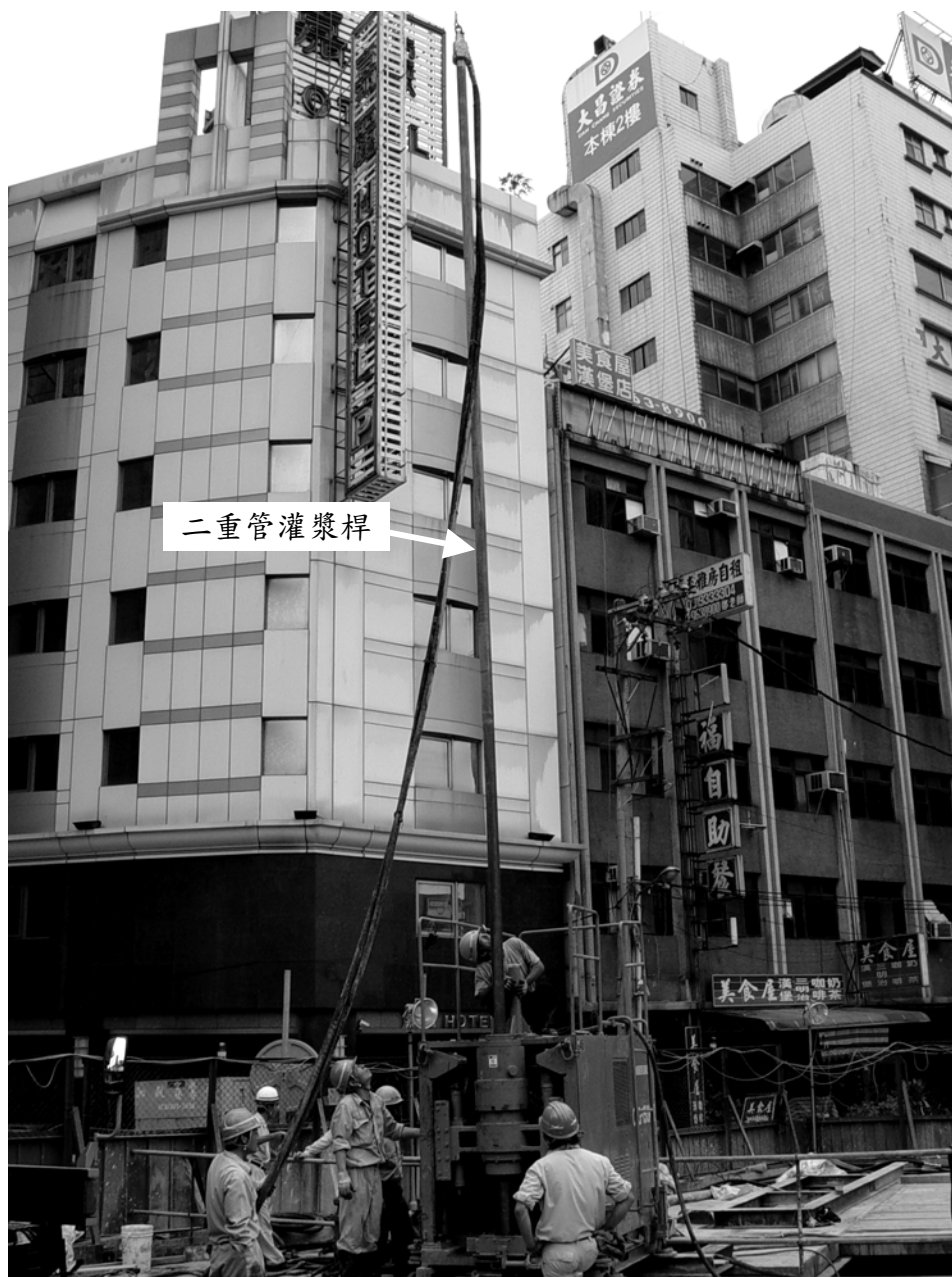
圖 6-3 定速旋轉提升二重管灌漿桿 (摘自 簡國峰, 2003)
