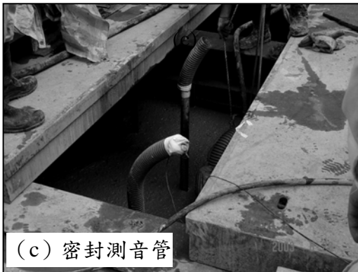
圖 6-7 SJM 地盤改良之噴射音確認過程
