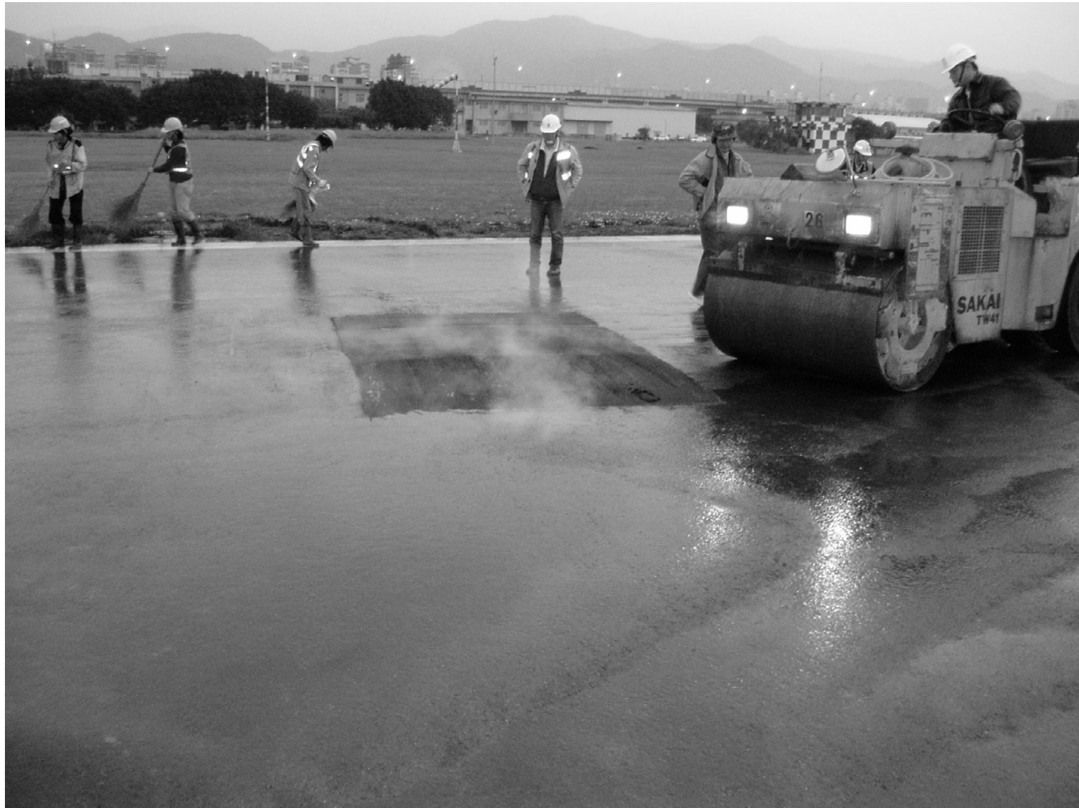
圖 8-15 跑道隆起狀況 (摘自 大陸工程, 2004)
