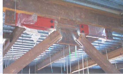
圖 1.13 Ambulatory Care Center 及摩擦阻尼器施工安裝照片【35】
