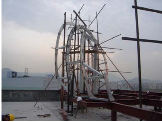
Figure 4.35 骨架運送組裝(a-e)
