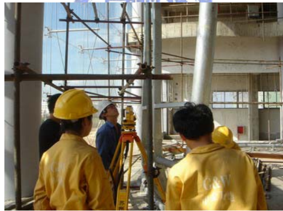
Figure 4.36 主體組裝校正
