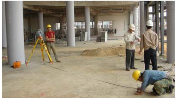
Figure 4.26 現場尺寸測量
