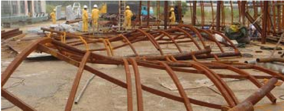
Figure 4.32 主體骨架分批拆解
