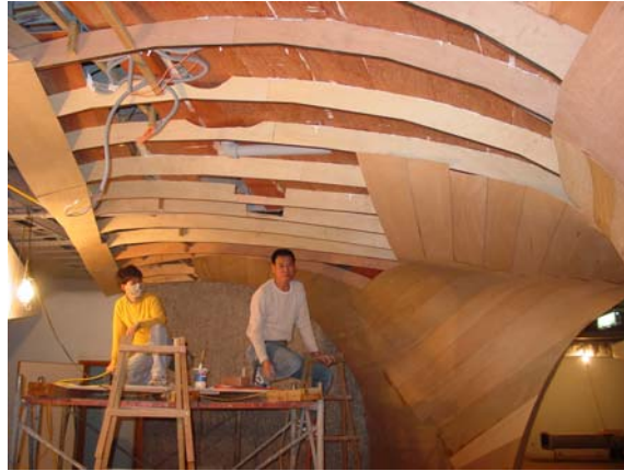
Figure 3.11 木骨架及矽酸鈣板施工現況
