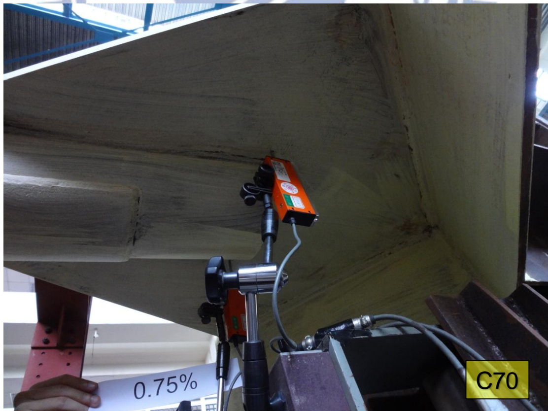
圖 4.83 試體 C70 斜撐北端接合板下緣石膏漆開始脫弱(1) (DR=0.75%)
