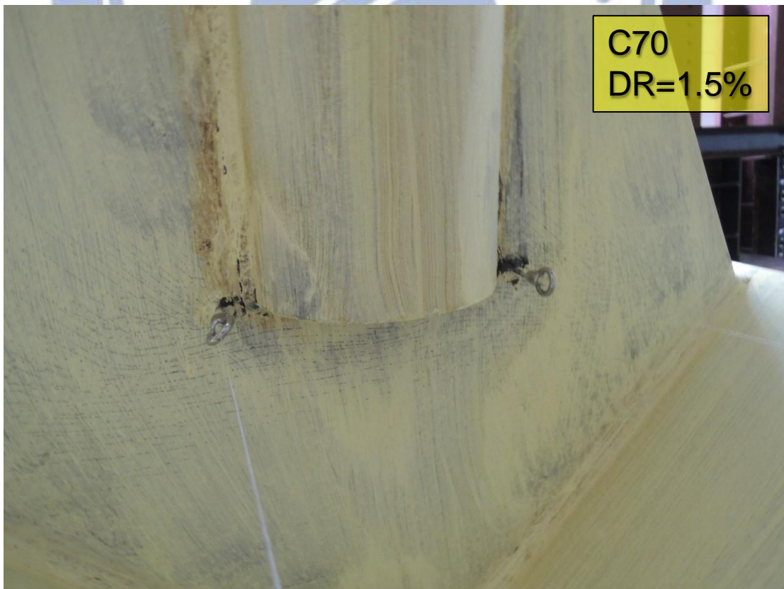
圖 4.89 試體 C70 斜撐南端接合板下緣石膏漆開始脫弱(1) (DR=1.5%)
