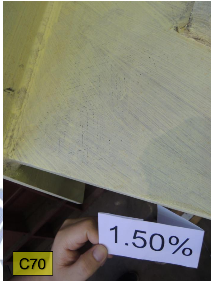
圖 4.88 試體 C70 斜撐南端接合板上緣石膏漆開始脫弱(2) (DR=1.5%)
