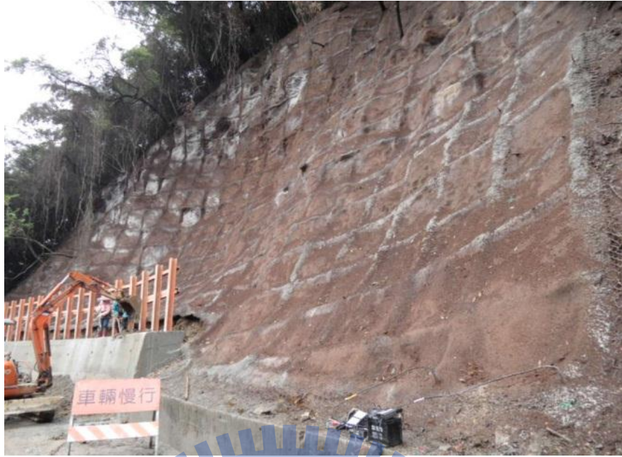
圖 4-12 土釘及自由樑護坡現場施工完成圖
