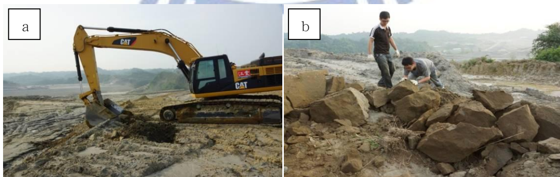
圖 4-1 a.怪手開挖 b.挑選適用之岩塊
