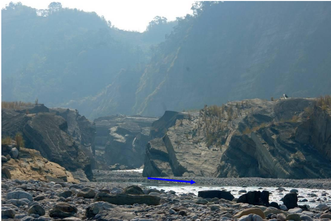
圖 2-11 大安溪下游平面滑動後殘餘的河道邊坡(經濟部水利署水利規劃試驗所，2010)
