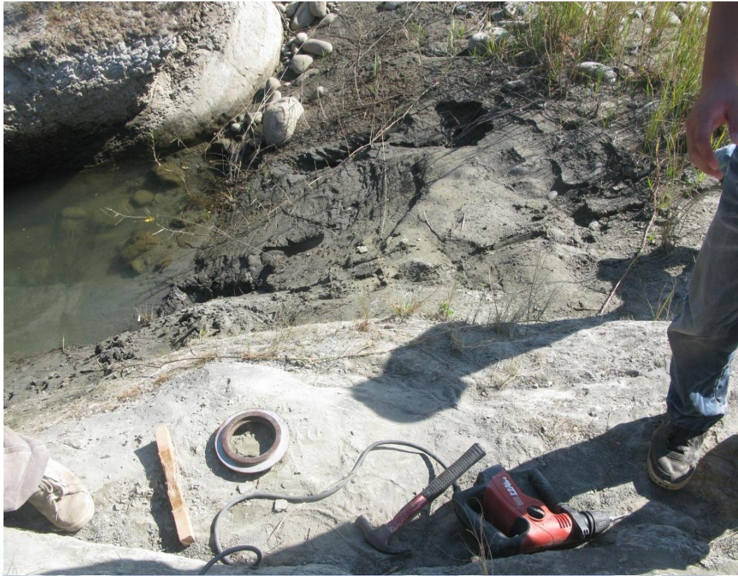
圖 3-1 以預鑽方式將銅製底座打入軟岩中
