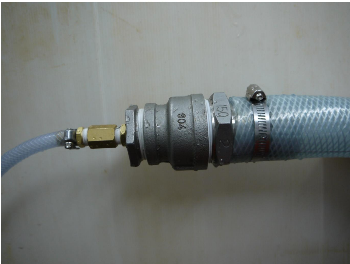
圖 3-45 2in 縮至 3/8in 轉接過程(外部管路)
