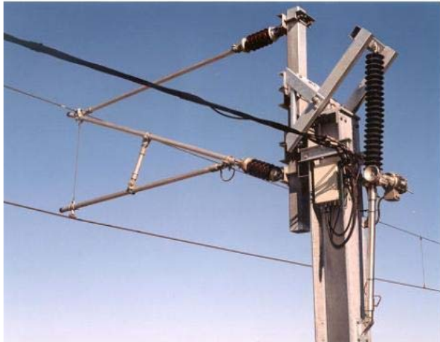
Figure 26. Pictures of a Kippfahrleitung Mast in Down and Up Position
