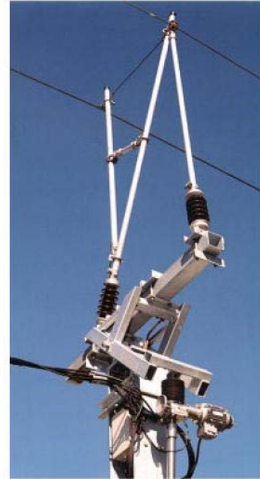
Figure 26. Pictures of a Kippfahrleitung Mast in Down and Up Position
