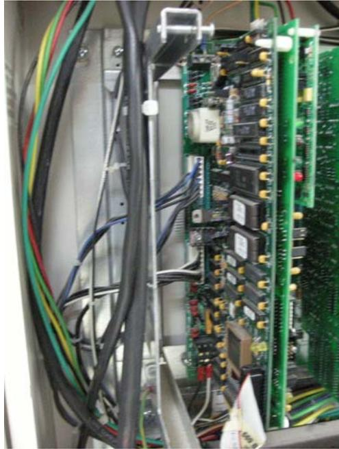
圖 3.3 火警受信總機 CPU 卡
