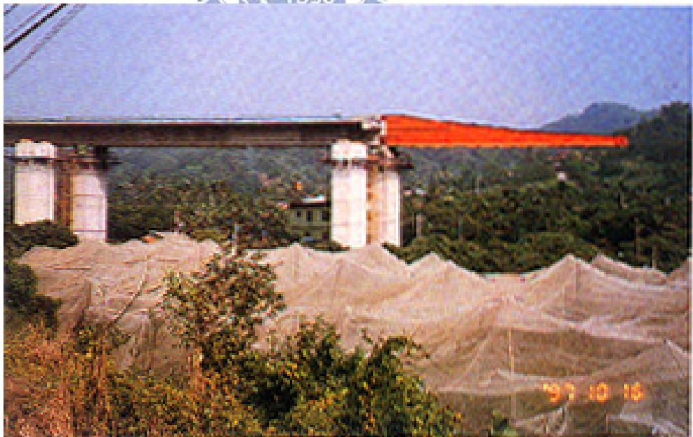
【圖2.2】節塊推進工法
