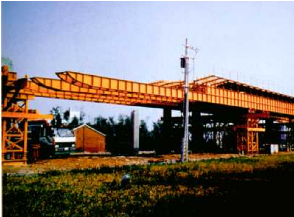
【圖2.1】支撐先進工法
