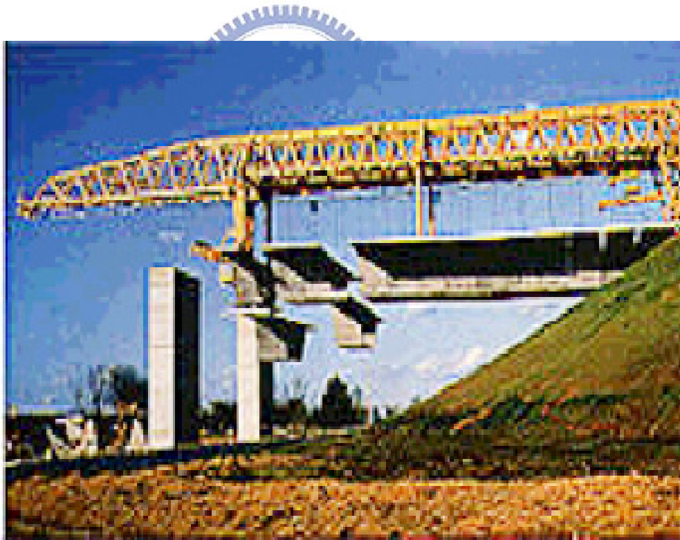
【圖2.4】預鑄節塊工法
