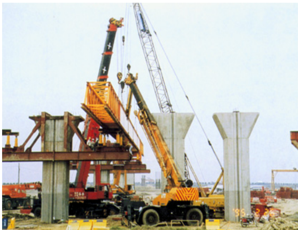
圖 3.25 鼻梁與主鋼梁組裝
