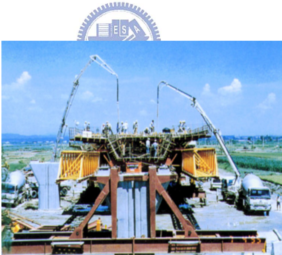
圖 3.20 澆置混凝土
