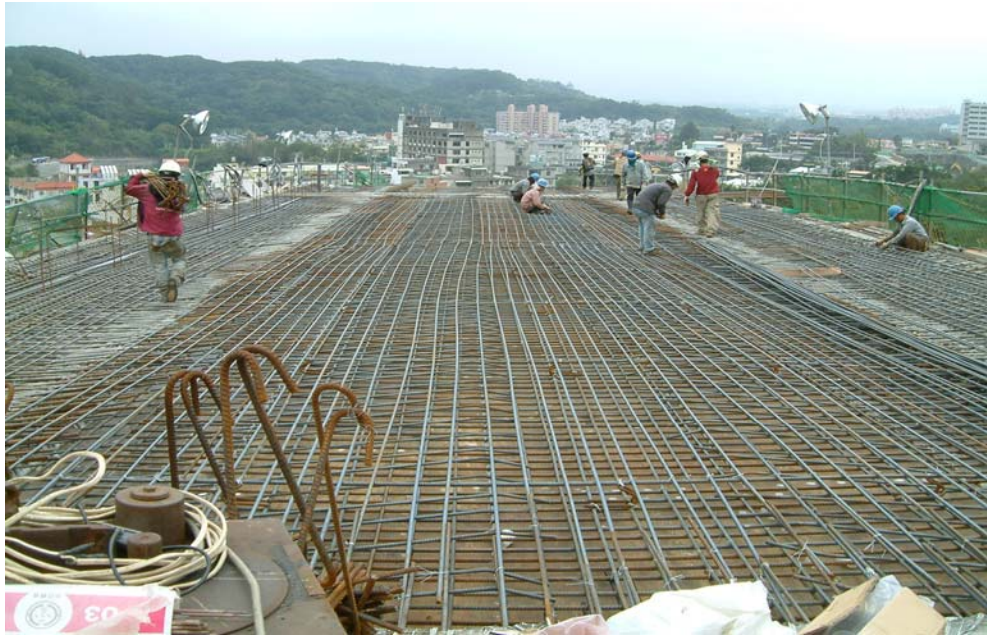
圖 3.19 頂版鋼筋彎紮、檢測高程
