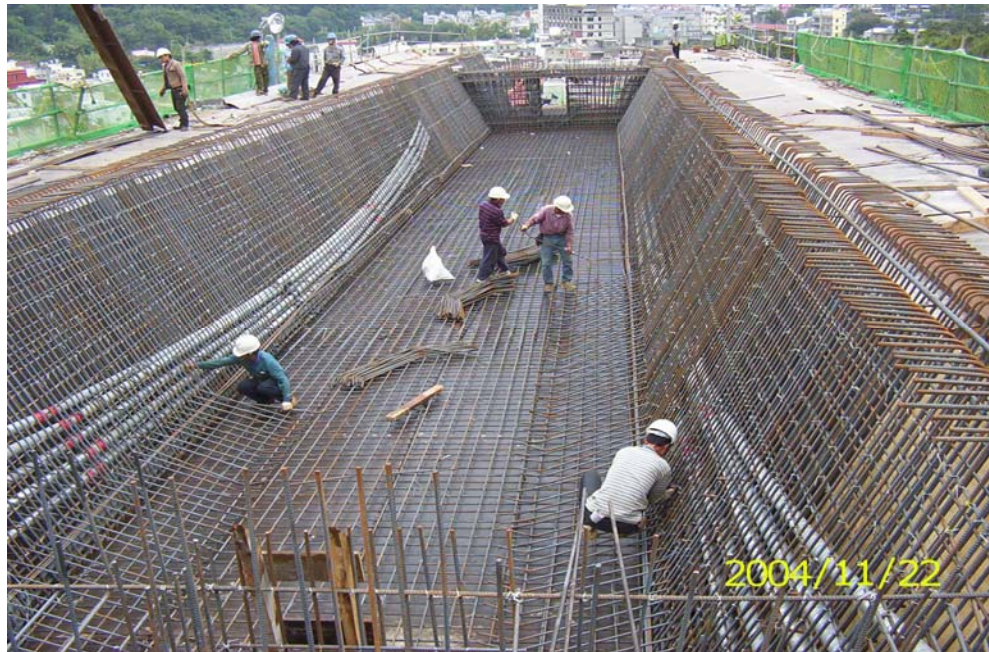
圖 3.17 底、腹版鋼筋彎紮及配置預力系統
