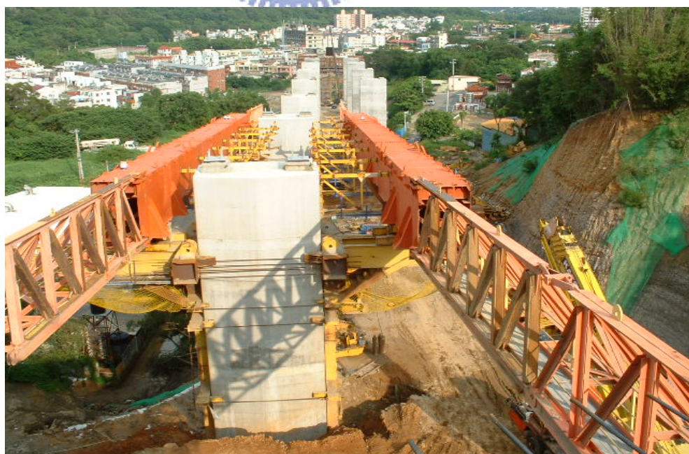
圖 3.26 底模橫梁組立完成
