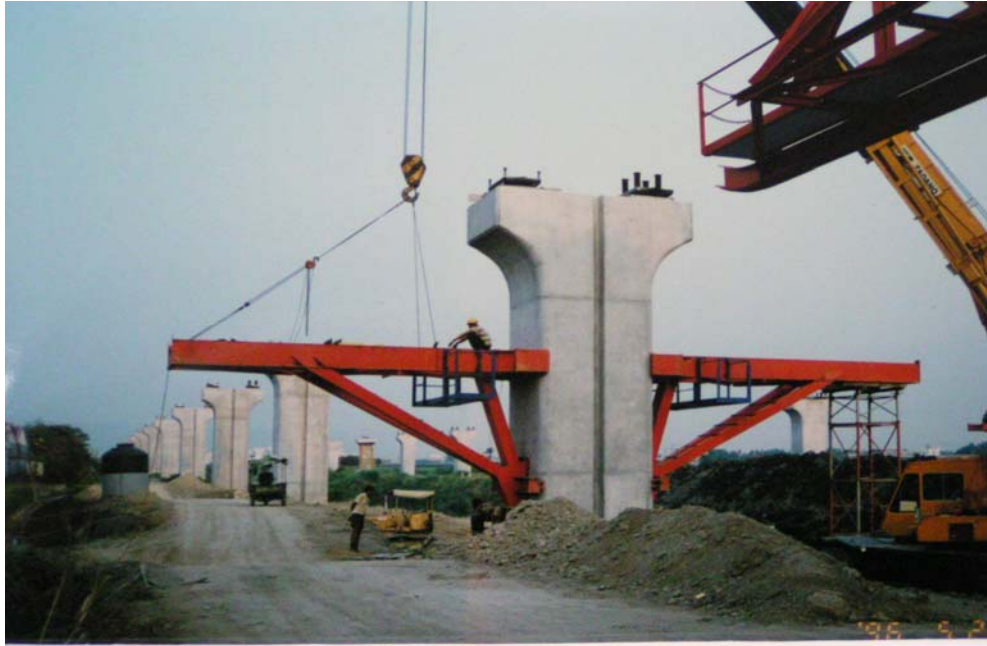
圖 3.13 支撐托架安裝
