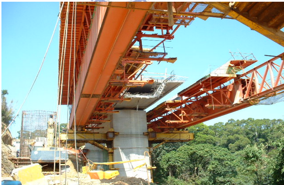
圖 3.14 主樑及系統模利用油壓系統完成脫模及橫移
