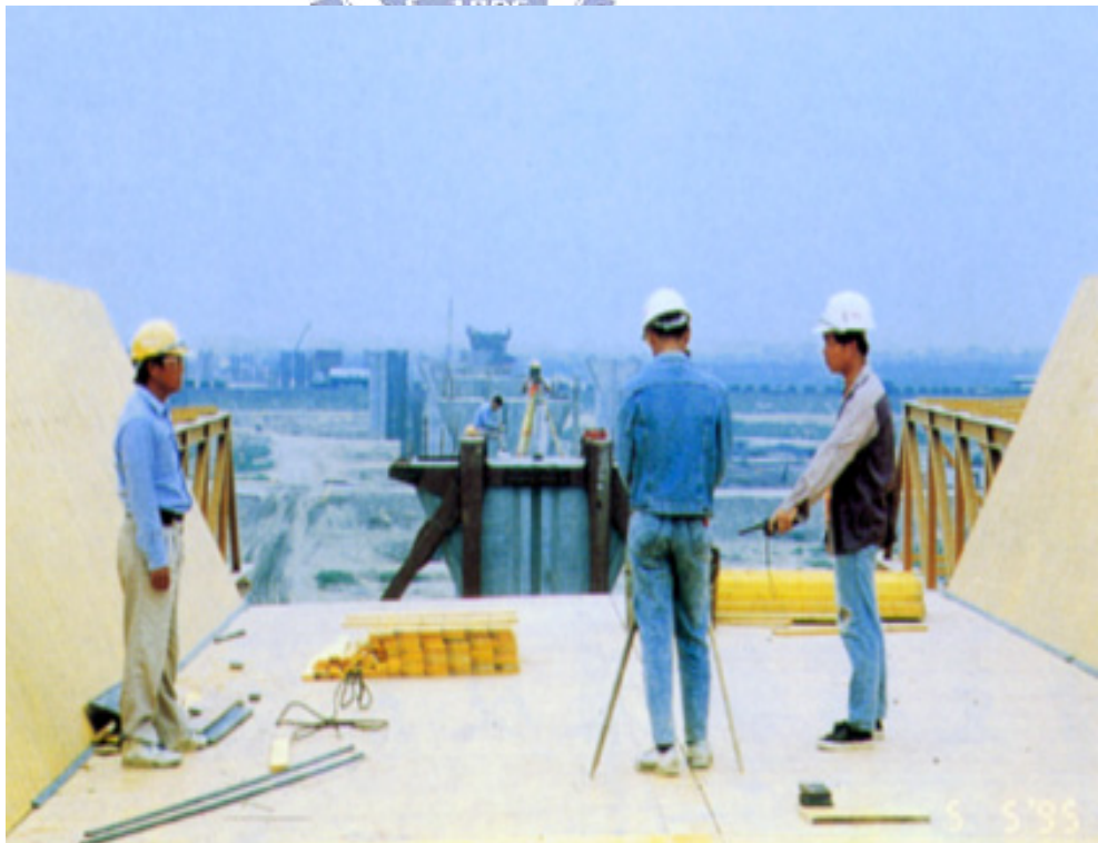
圖 3.16 檢核主鋼樑及系統模正確位置
