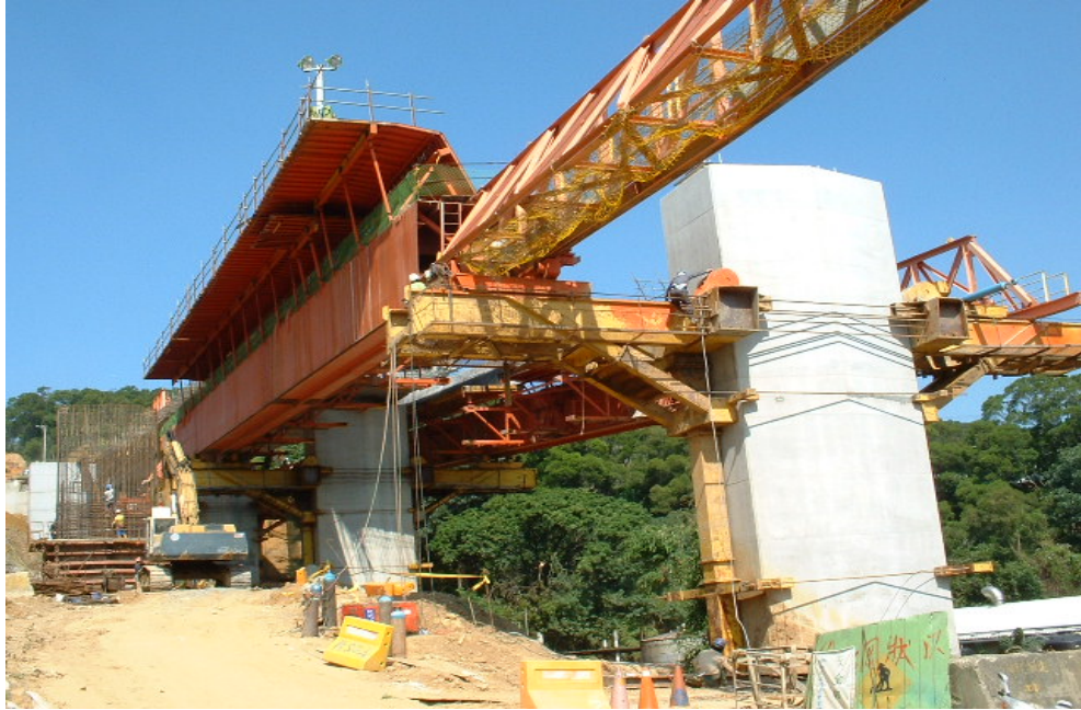
如圖 3.15 工作車藉由油壓設備推進
