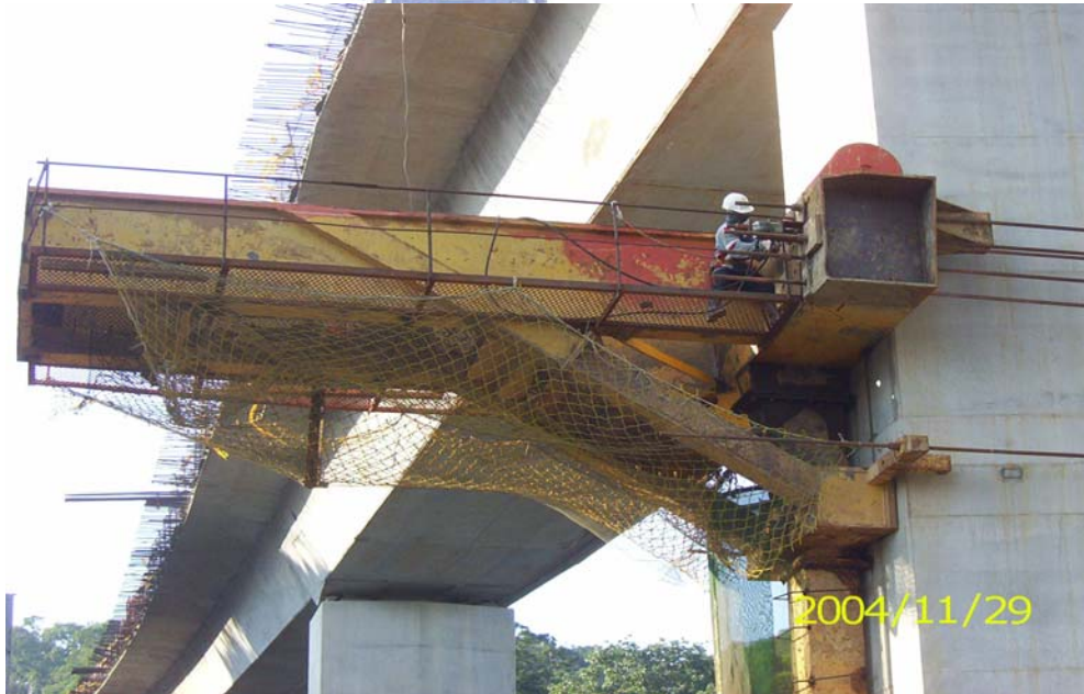
圖 3.22 下撐式托架及高拉力鋼棒安裝
