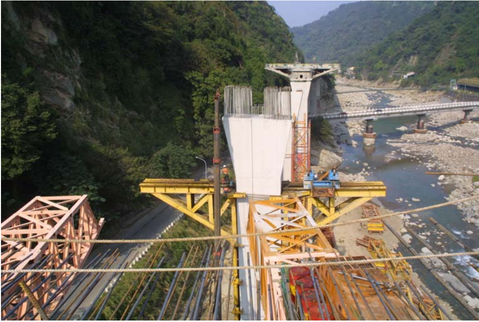
圖 4.7 線形曲率半徑為 300m 使工作車設備無法推進三角托
