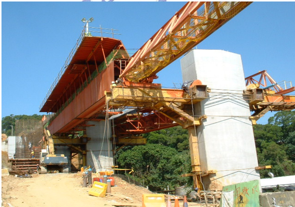
圖 3.32 主梁及系統模藉由油壓推進工作車推進
