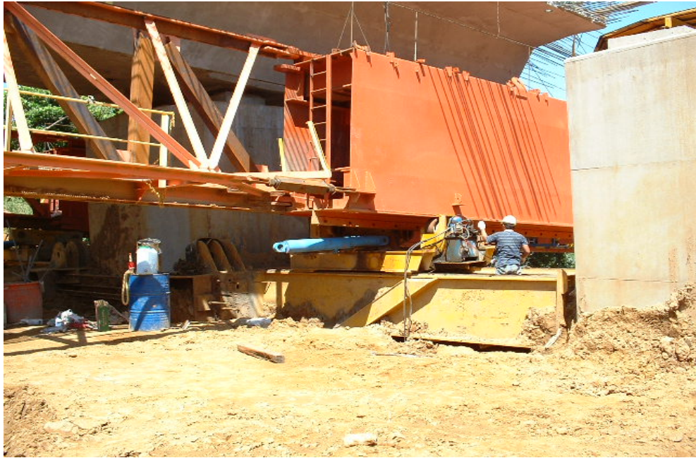
如圖 3.31 主梁坐落於前進滾輪工作台車上
