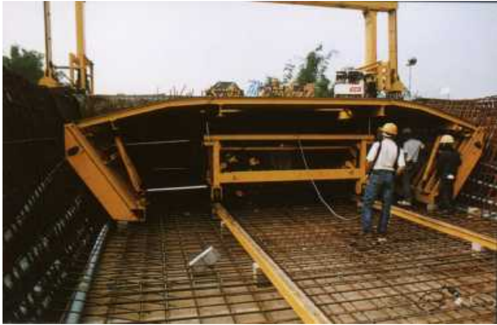
圖 4.1 內模工作台車及軌道安裝
