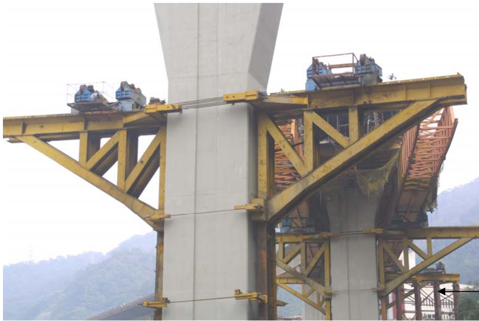
圖 4.8 後方加設臨時支撐以利主梁推進
