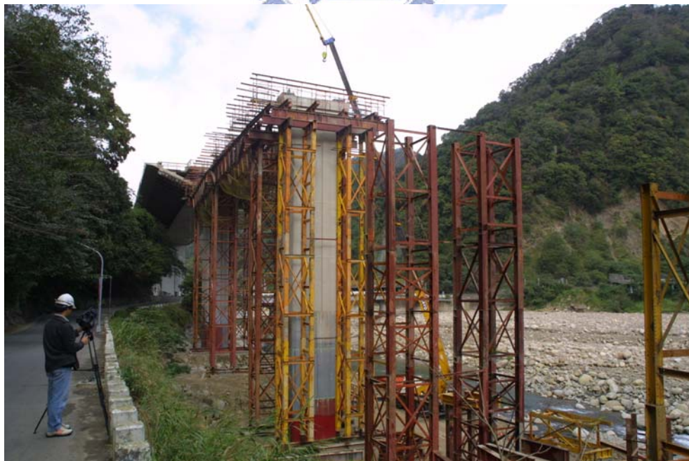
圖 4.9 就地支撐工法替代
