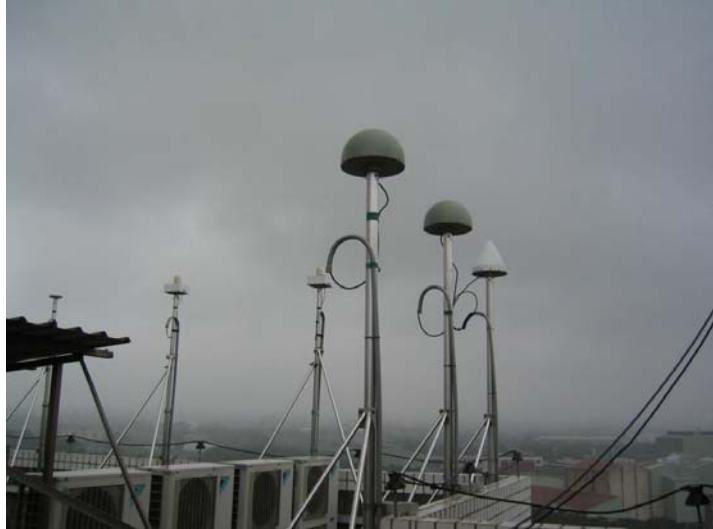
圖 4-5 TWTF 站所使用的天線盤
