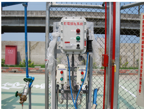
圖 69、靜電接地系統
