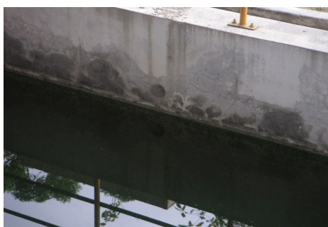
圖 33、消防水池水量足夠消防栓及灑水設備作動 30 分以上
