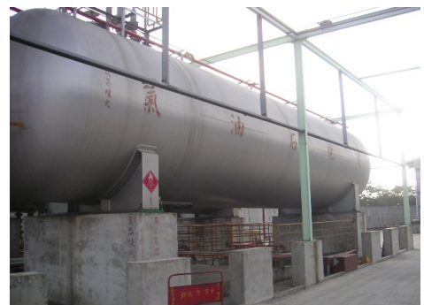
圖 18、儲槽本體表面以紅漆書寫「液化石油氣」以標示內容物名稱
