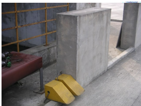
圖 31、槽車輪檔及接地夾頭
