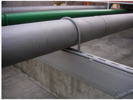
圖 7、管路以明管架設固定方式
