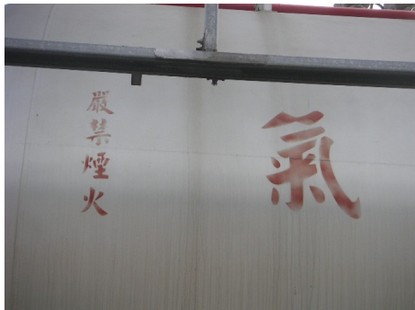
圖 21、儲槽本體表面以紅漆書寫「嚴禁煙火」以警示煙火管制區域
