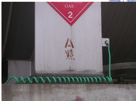
圖 15、儲槽接地線
