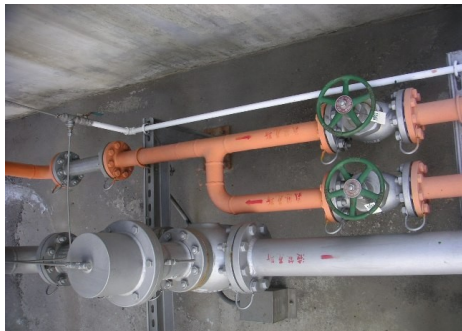
圖 9、管路以明管架設固定方式
