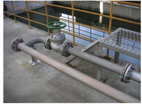
圖 8、管路以明管架設固定方式
