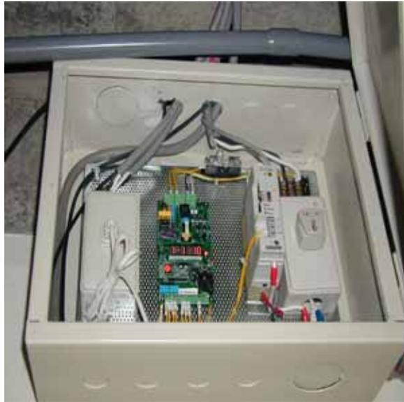
圖 51 冷氣機控制器施工相片
