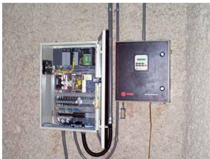
圖 47 冰水主機卸載控制信號盤
