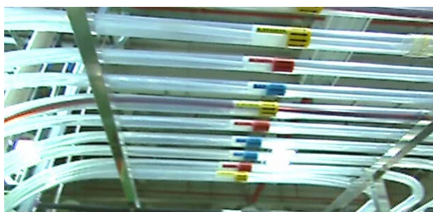
圖十一：自動供酸管線圖
