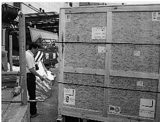
圖 4.6.3 業主倉管人員先目視確認機台外包裝有無異常情形，再由搬運商進行拆箱作業。
