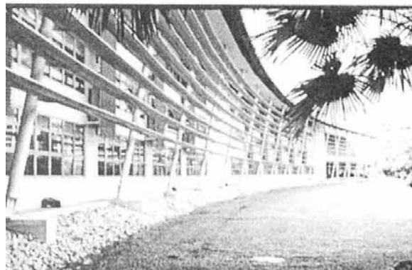
圖 16：新加坡某學校遮陽設計實例（資料來源：綠建築設計技術彙編）
