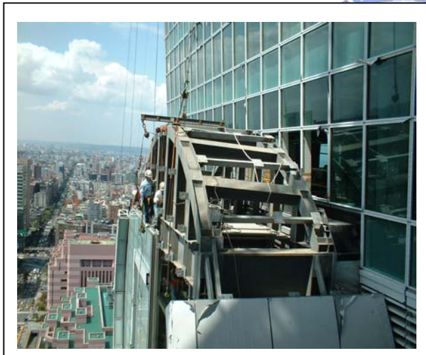
照片 4.6 塔樓圓形徽章版片吊裝
