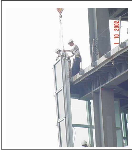
照片 4.4 塔樓角隅單元吊裝
