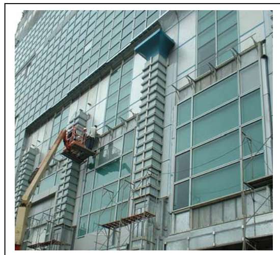
照片 4.3 裙樓單元吊裝
