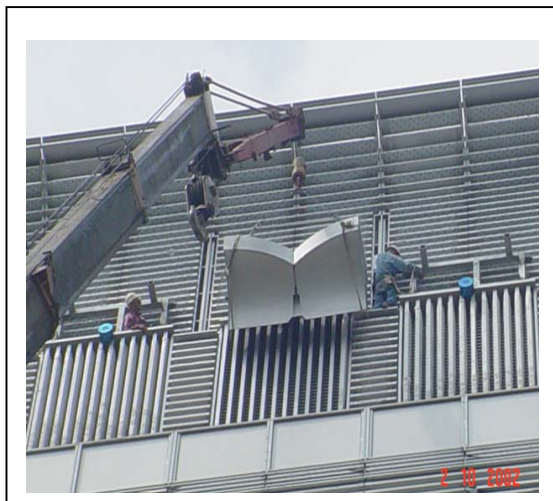
照片 4.2 裙樓造型單元吊裝
