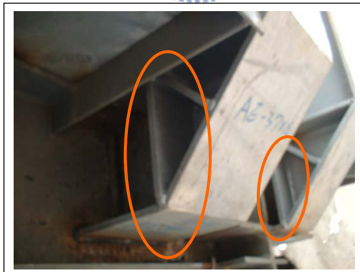
照片 5.11 塔樓角隅加勁鈹焊接位置
