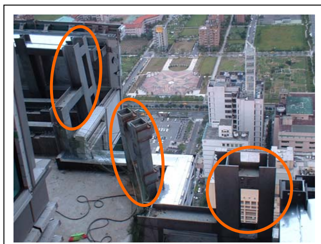
照片 5.13 角隅不鏽鋼造型支撐 H 鋼組立及焊接進度落後(右)
