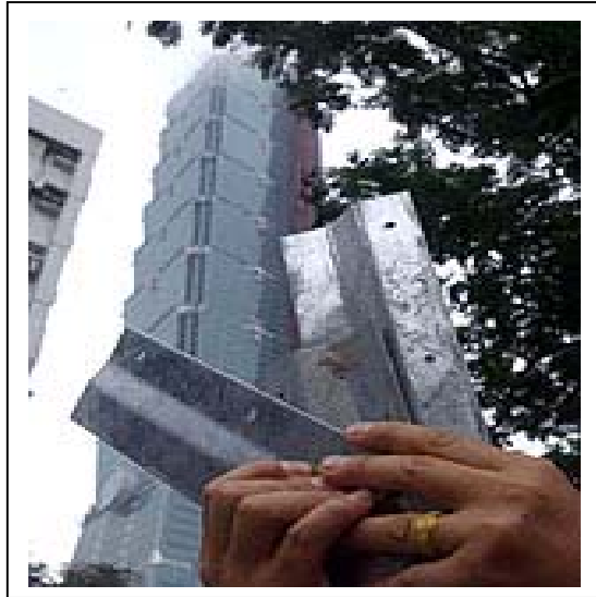
照片 5.22 塔樓 90F 鐵件搬運不慎掉落 搬運不慎地面
