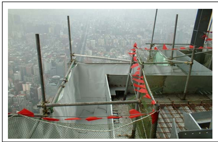
照片 5.21 電銲銲渣掉落防止措施
