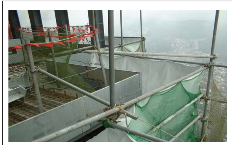
照片 5.20 電銲銲渣掉落防止措施
