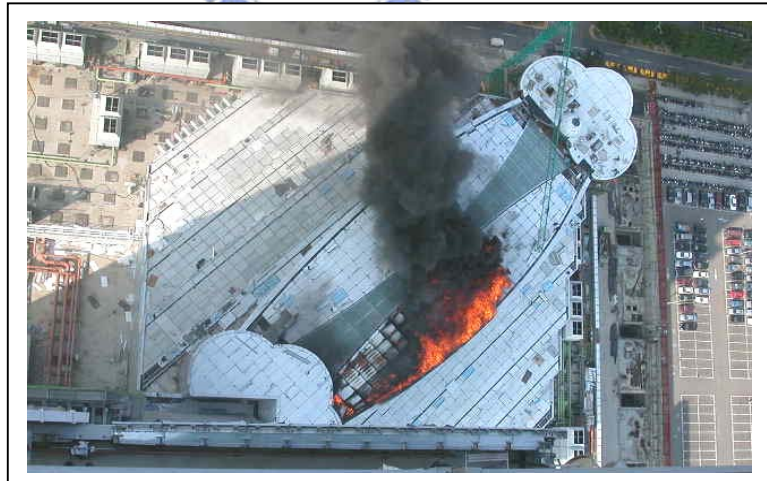
照片 5.18 火災事故---裙樓東北側屋頂採光罩旁鋁包鈹火災。
