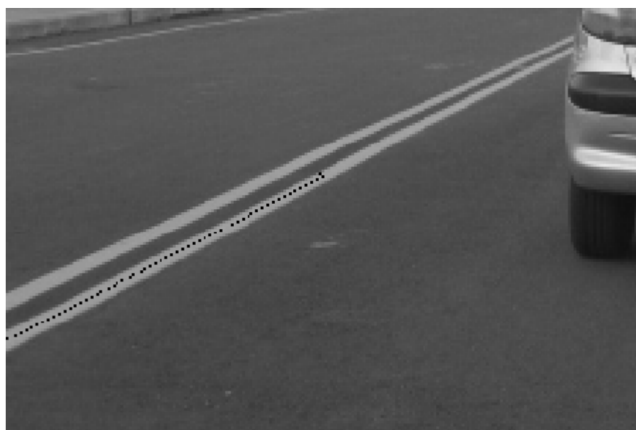
Fig. 3-11 道路標線左右邊緣的中點，並非完全在一直線上。
