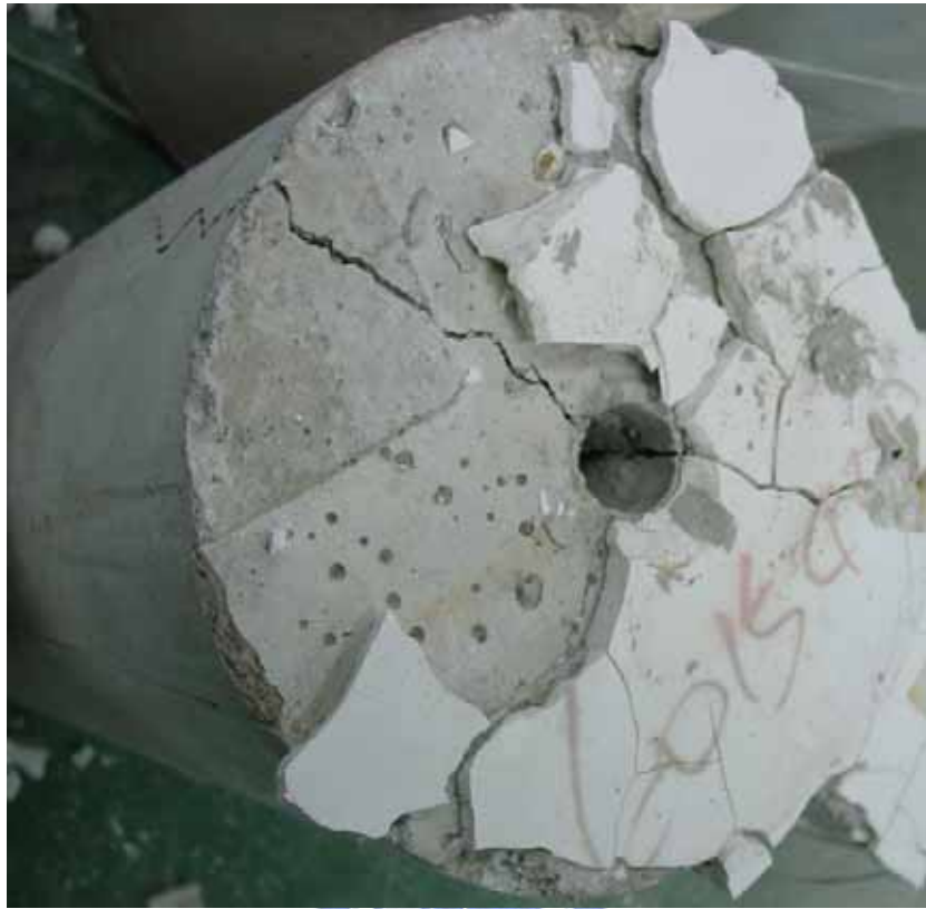
圖 4-15 中心溫度 400°C，D19 一般鋼筋埋深 15d b 試體的劈裂情形
