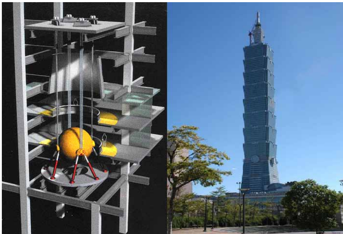
圖 1.1 台北國際金融大樓與單擺式 TMD 系統
