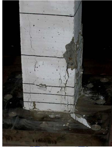
(b) 混凝土保護層剝落： 位移達 1.30\Delta_{p_0} 時
