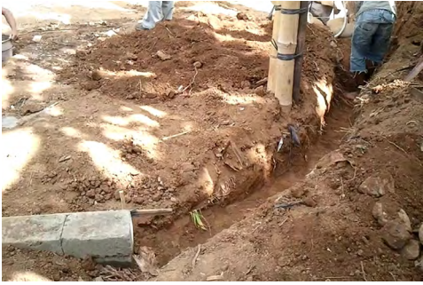
建築基地邊界挖出溝槽放入水泥磚收邊
