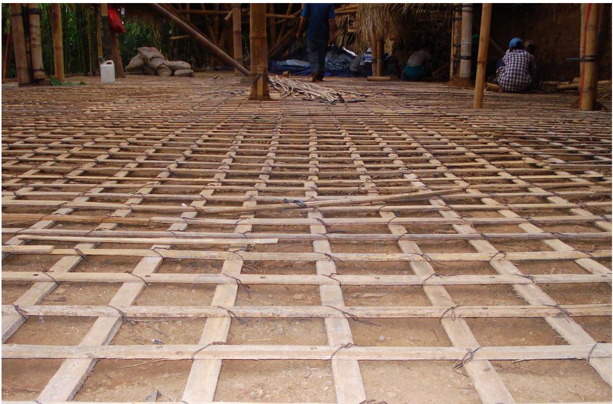
編織竹筋增強水泥地平的結構
