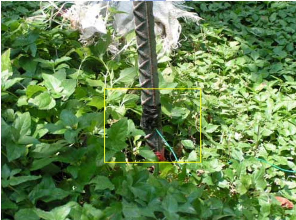
圖 3.11 接地線延伸至大地表面
