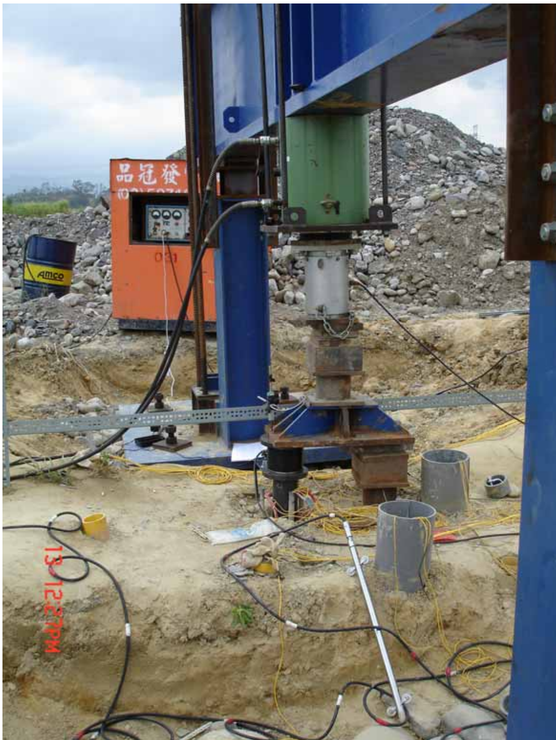
圖 3- 10 (b)試驗之鑽孔完成後之情形
