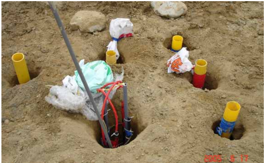
圖 3-15(a) 現地樁體及測傾管埋設完成實體圖
