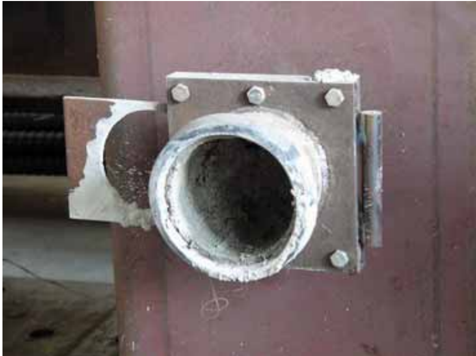
照片 3.3 CFT 柱灌漿閥門
