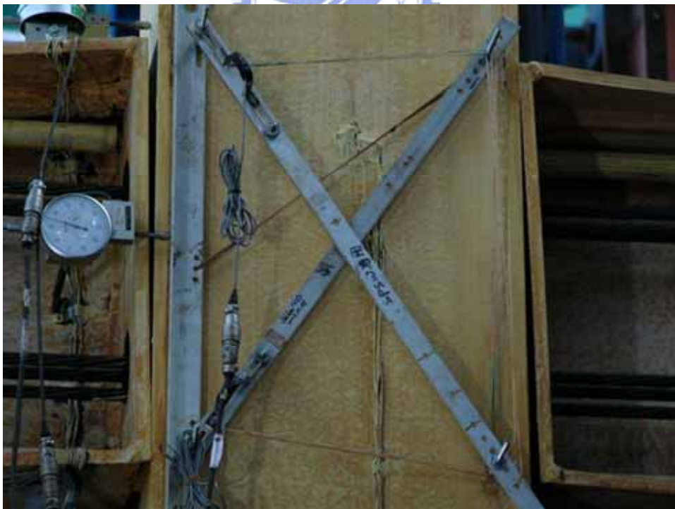
照片 4.8 試體 S1-4 於 3.0% 時梁柱接合面縫隙
