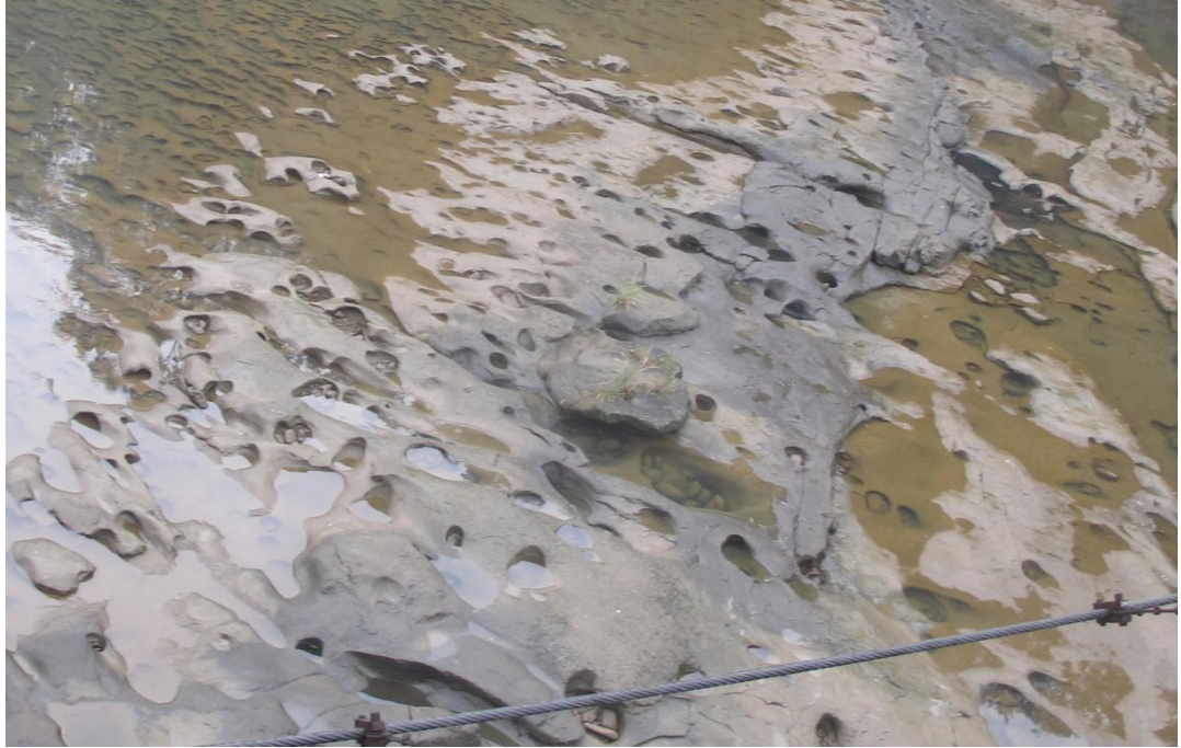
圖 2-2 平溪四廣潭吊橋之壺穴
