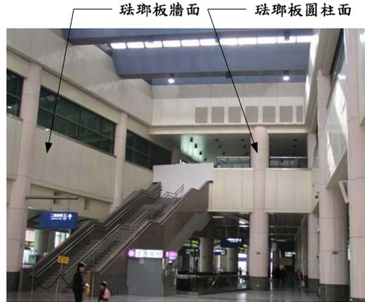
圖 3.5 瑠璃板牆面與瑠璃板圓柱面示意
