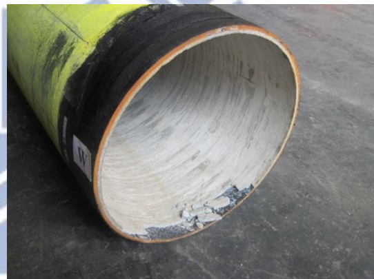
(b) 插口內襯水泥剝落
