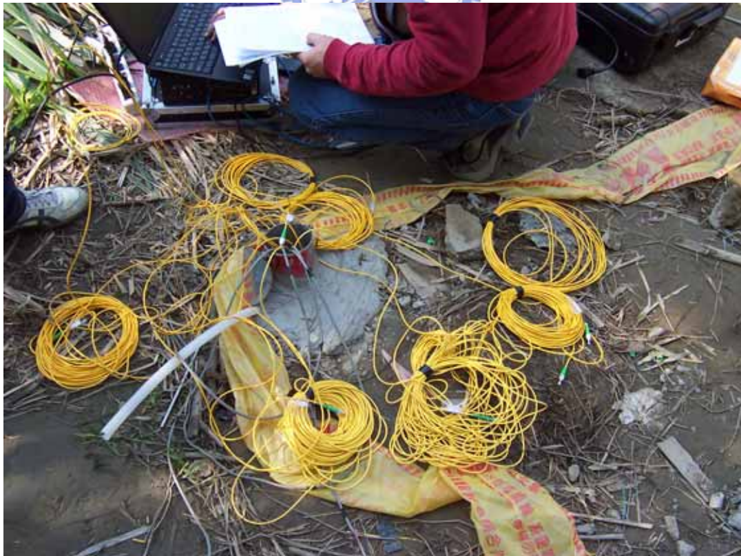
圖 5-11 孔 CB73-1 裝設結束情況
