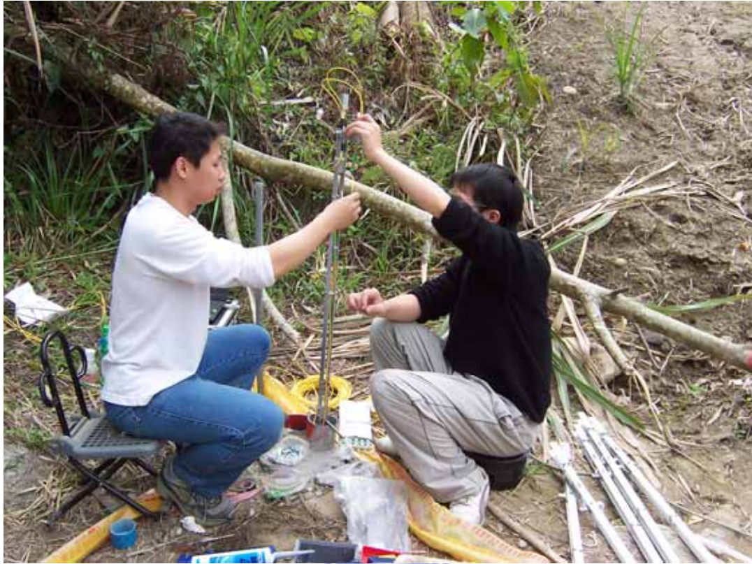
圖 5-10 孔 CB73-1 現場裝設情況
