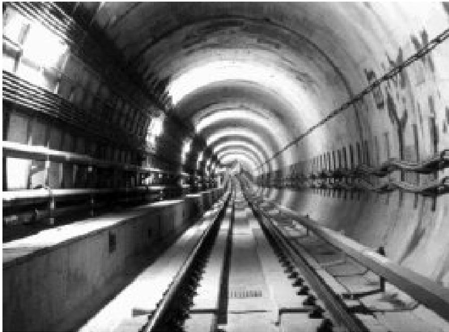
圖 2-31 捷運新奧工法隧道完成工圖
