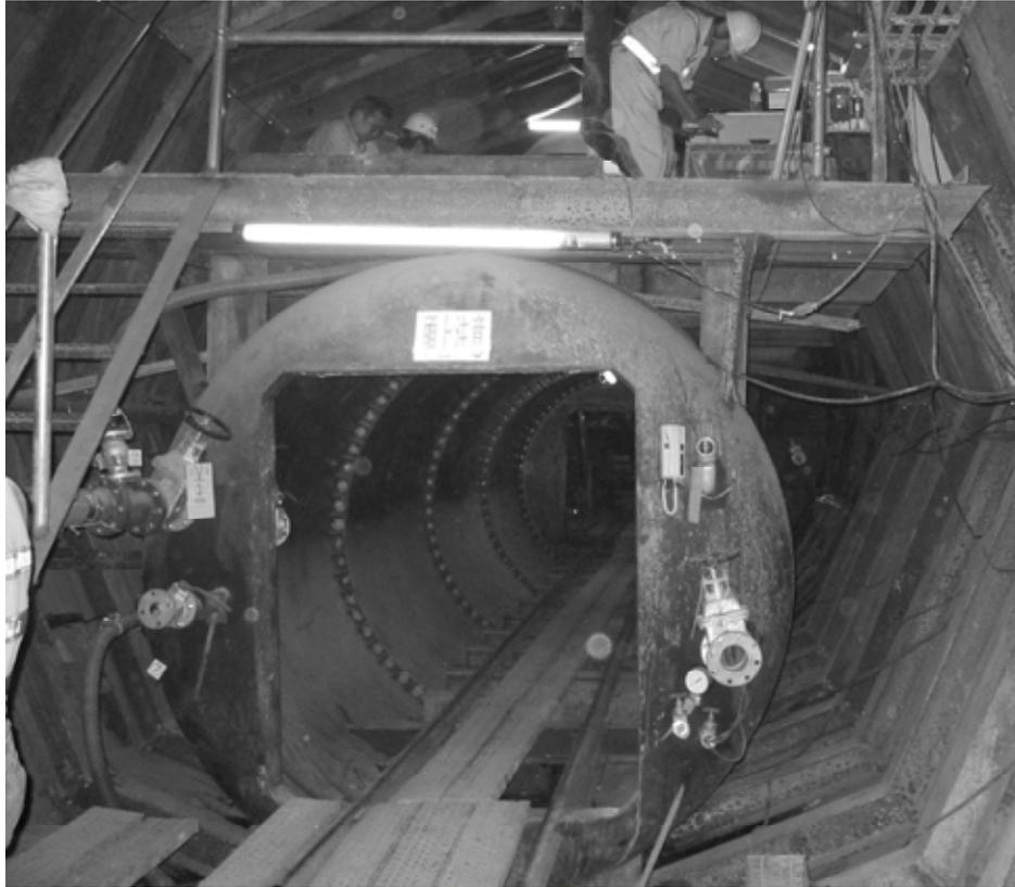
圖 2-12 土城線 CD266 標潛盾隧道內之壓氣艙設備
