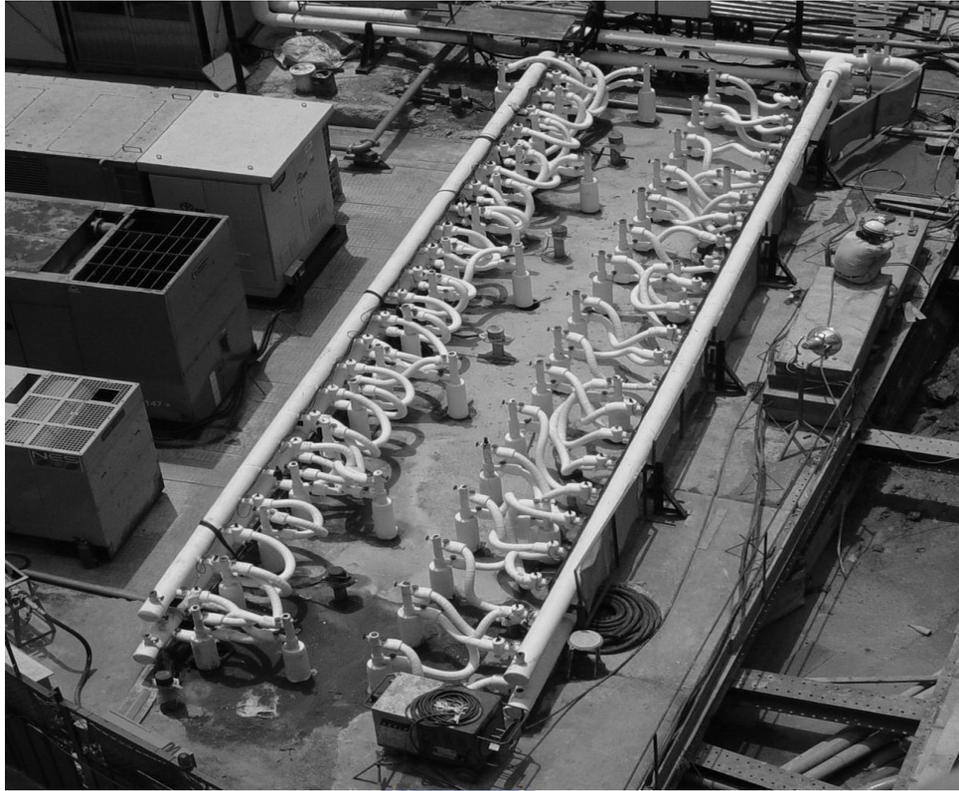
圖 2-14 土城線 CD266 標冷凍工法地面施作狀況
