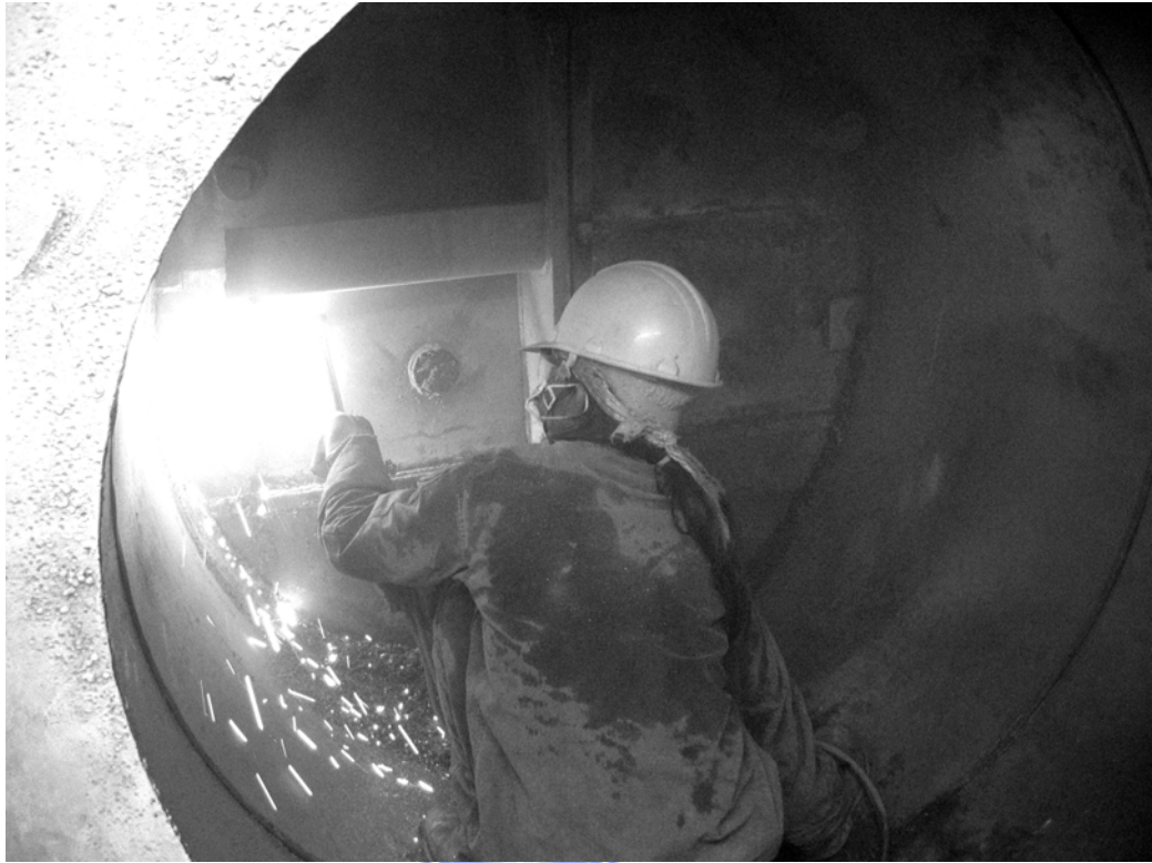
圖 3-19 施工人員切除潛盾隧道於聯絡通道處之鋼環片
