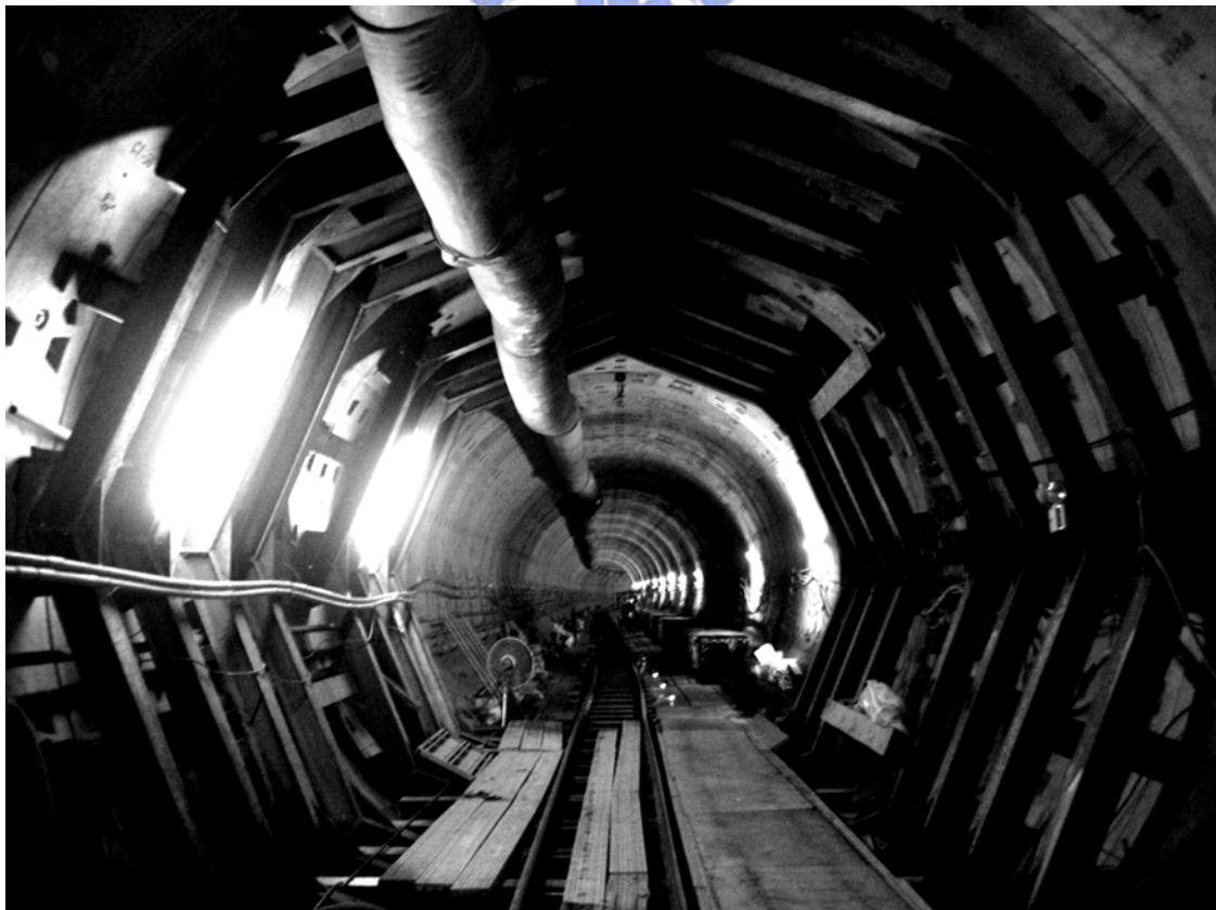
圖 3-11 潛盾隧道內架設八角內支撐
