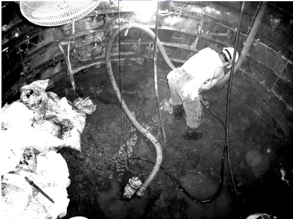
圖 3-22 集水井開挖作業
