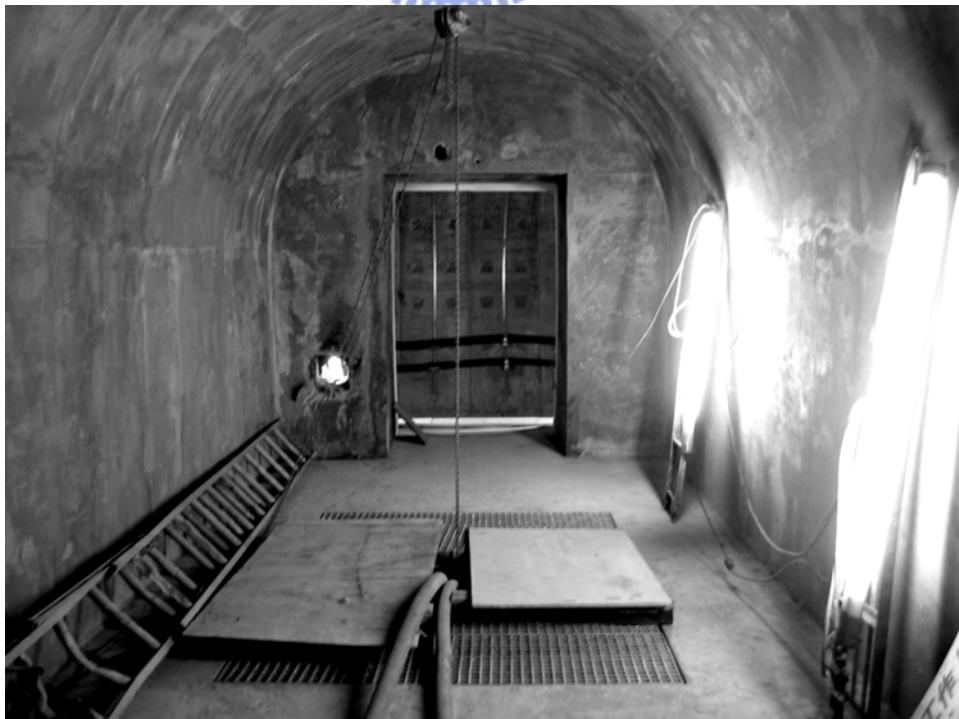
圖 3-24 聯絡通道施工完成
