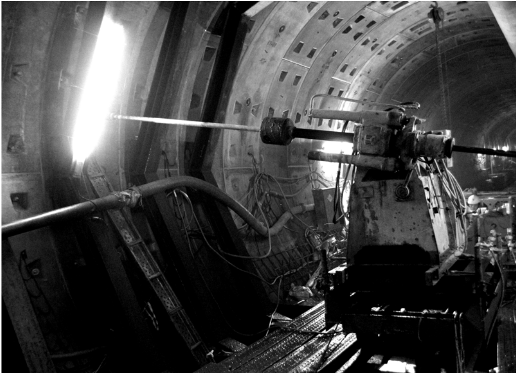
圖 3-13 聯絡通道開挖前藥液灌漿施作
