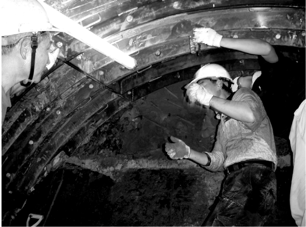
圖 3-21 聯絡通道開挖鋼環片支撐架設作業
