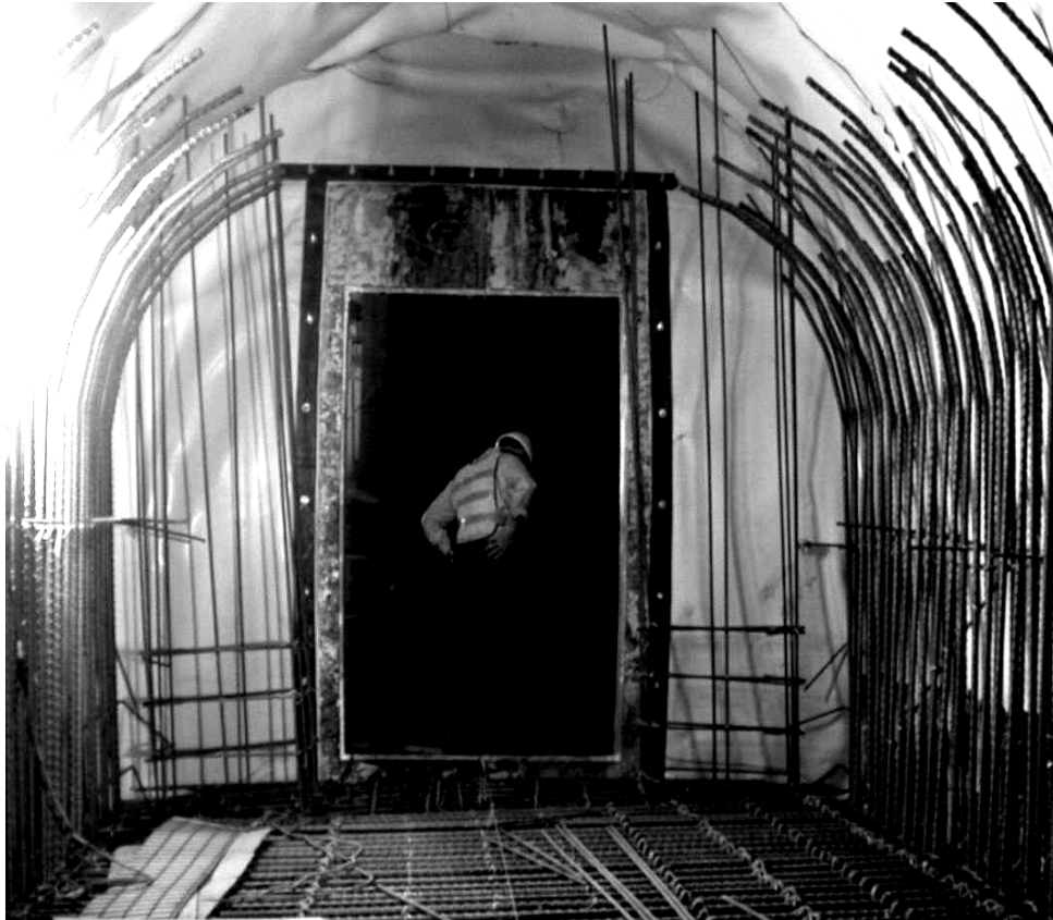
圖 3-23 鋪設防水膜及組筋
