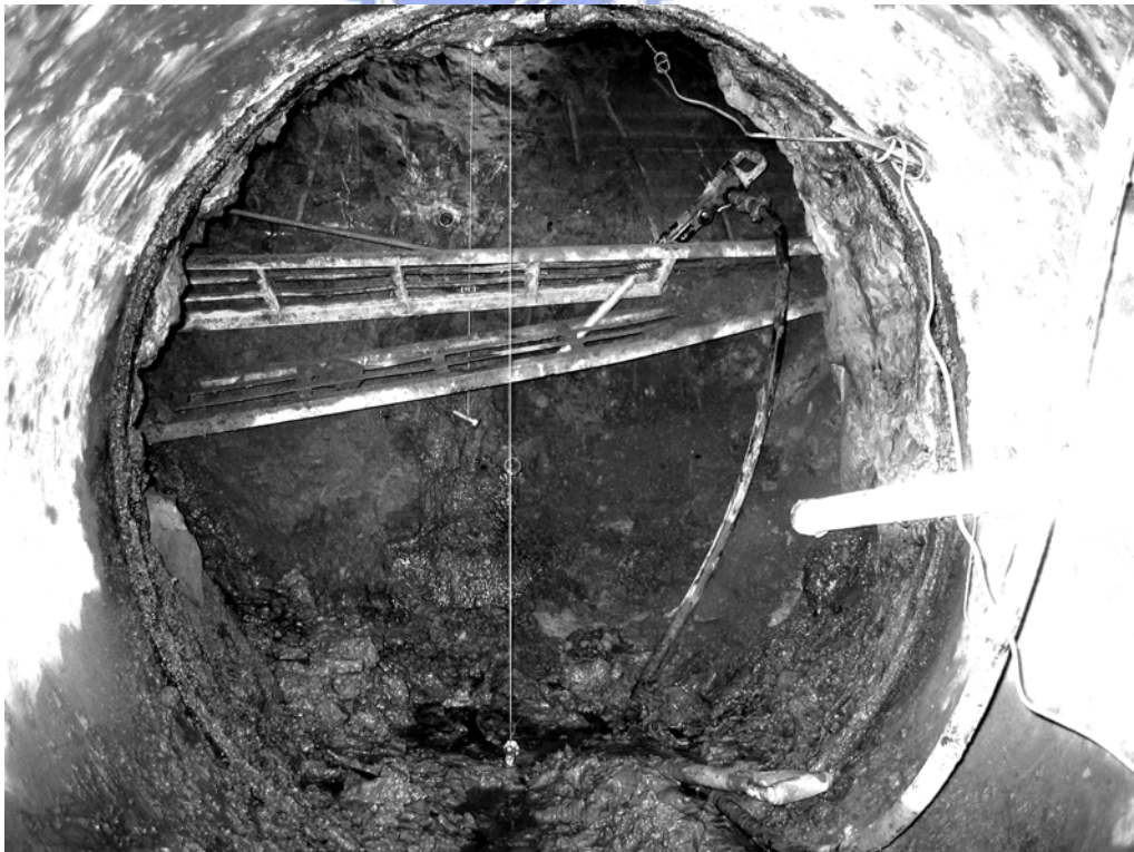
圖 3-20 切除鋼環片後之入口開挖作業
