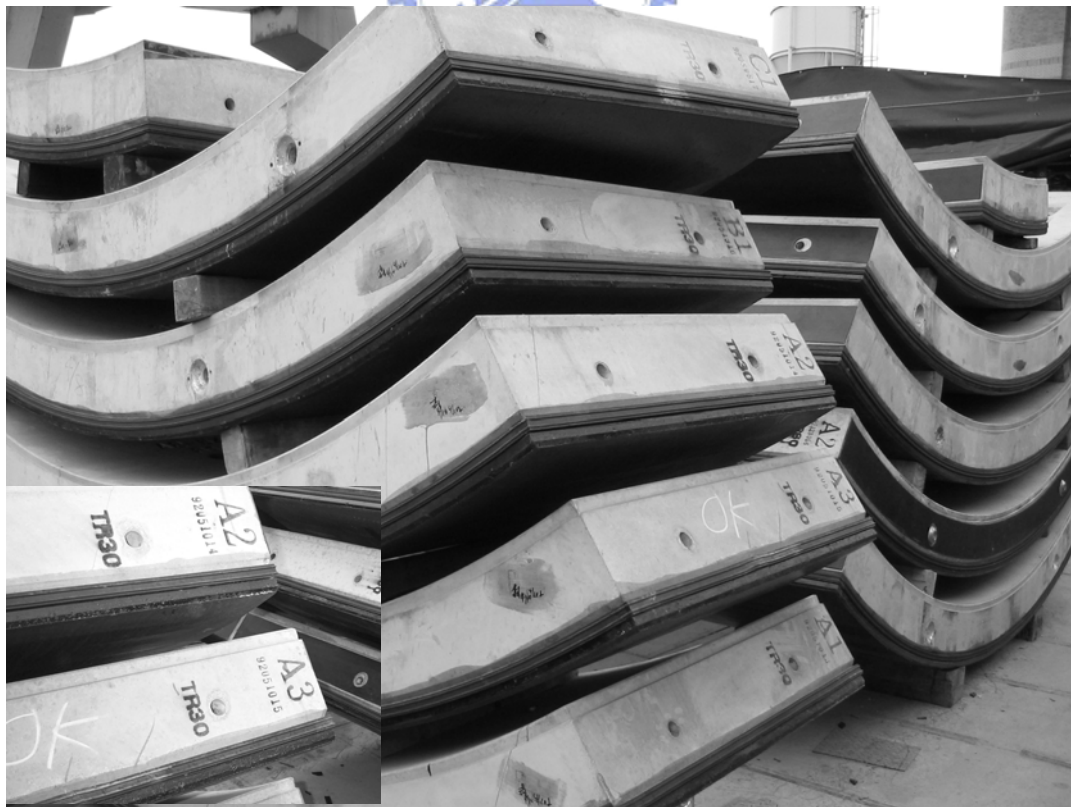
圖 4-13 異形量 30 mm 之隧道襯砌環片
